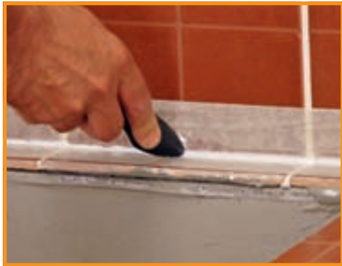
18. Cu o spatulă din material plastic, s-a îndepărtat ușor surplusul de silicon.
