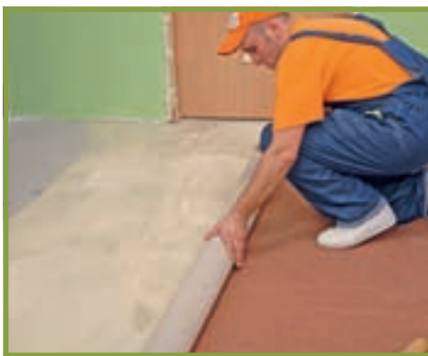
19. Mocheta se derulează cu multă atenție, evitându-i deformarea, peste patul de adeziv aplicat.
