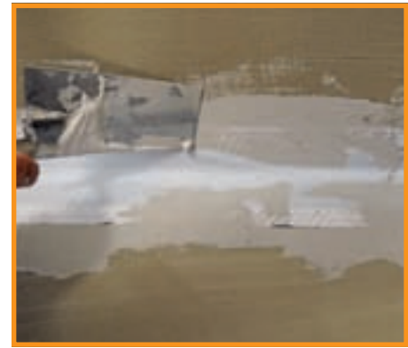
5. Banda de etanșare se înglobează în pastă, la colțuri și în zonele de străpungere cu țevi.
