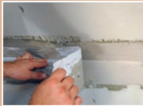
3. Colțurile se protejează suplimentar cu bandă hidroizolantă ce se aplică peste primul strat de pastă.
