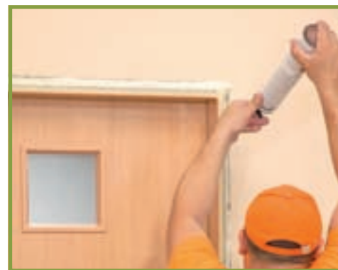
6. Spuma poliuretanică a fost aplicată de jos în sus, după ce pe suprafață a fost pulverizată apă.
