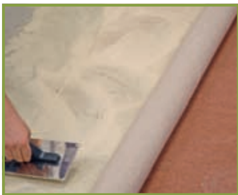
18. Adezivul rămas poate fi utilizat și la lipirea PVC-ului (desigur, tot cu o gletieră cu dinți).
