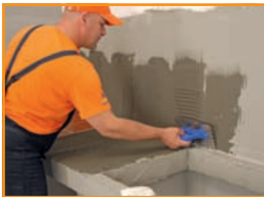
9. În sfârșit, a venit momentul placării cu faianță. Este necesar un adeziv flexibil, pentru exterior.
