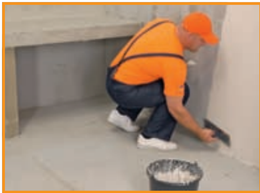
8. Timp de 2 ore, cât se uscă hidroizolația, s-a putut gleui porțiunea aferentă, care va fi vopsită ulterior.
