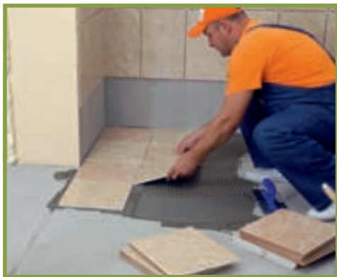
12. Până la uscarea gletului, s-a placat pardoseala cu gresie din aceeași gamă cu faianța.
