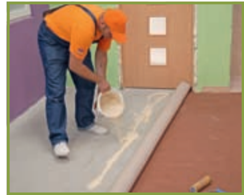
17. Restul pardoselii a fost acoperit cu mocheta, folosind un adeziv care, după uscare, rămâne elastic.
