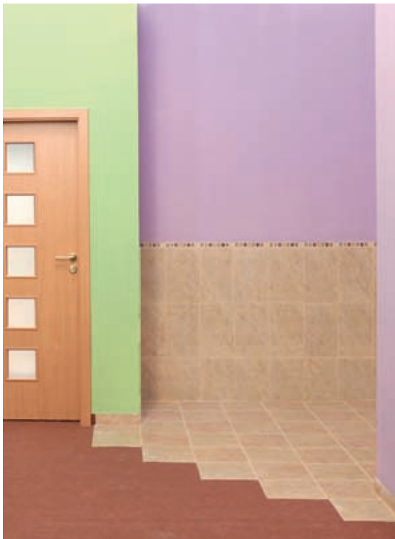
15. În același timp, un alt meseriaș a putut finaliza acoperirea cu faianță și a chituit întreaga placare.
