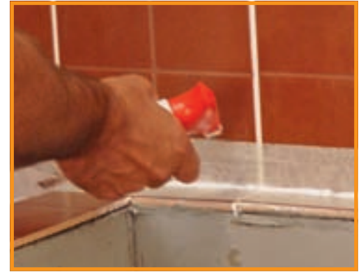
17. Apa folosită (de preferat una dedurizată) facilitează prelucrarea și întărirea ulterioară a produsului.
