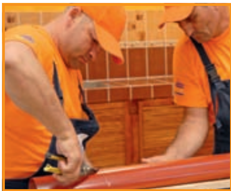
26. Numărul gurilor de evacuare depinde de regiul pluviometric al zonei în care se construiește.
