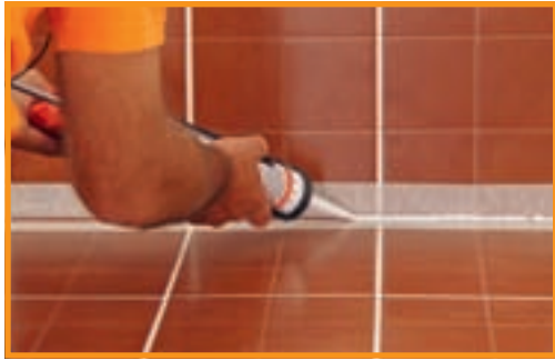
15. Placările ceramice au fost chituite cu un produs alb, acustatic, iar colțurile – umplute cu un silicon fungicid.
