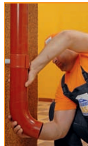
38. În sfârșit, se poate atașa și ultimul element, cel de evacuare.
