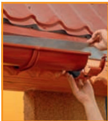
31. Pentru a asigura continuitatea și etanșeitatea jgheaburilor...
