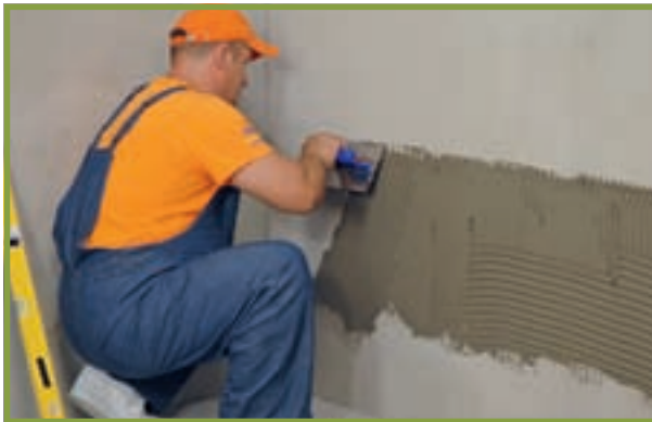
8. După ce adezivul pentru plăci ceramice a devenit o masă uniformă, a fost aplicat pe zid în strat subțire.
