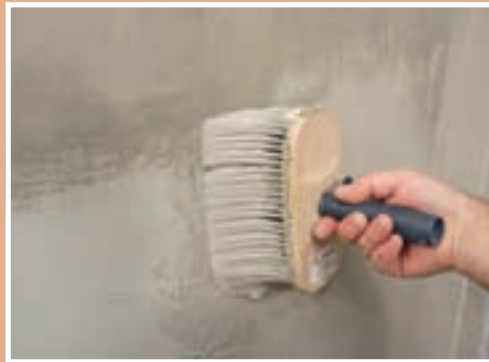
1. Prima etapă în finisarea unei băi este hidroizolarea, după o amorsare aplicată în prealabil.
