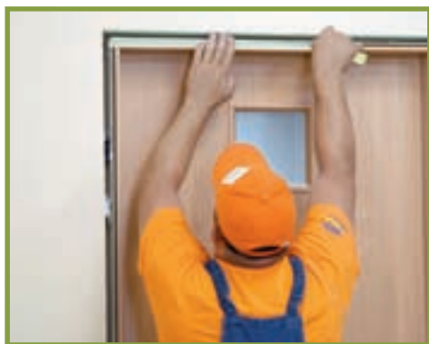
4. Între timp, s-a putut monta ușa. Din loc în loc, aceasta se fixează cu pene din lemn sau plastic.
