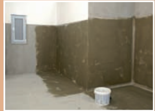
6. După uscare, hidroizolația va căpăta o duritate corespunzătoare și culoare specifică, mai închisă.
