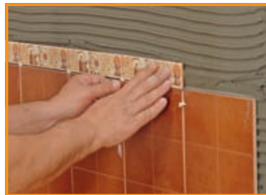
10. Detaliile de pe brâu care demarcă două tipuri de faianță personalizează placarea și îi conferă dinamism.
