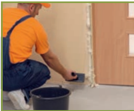
13. Pereții gletuiți au fost tratați cu o amorsă în urma aplicării căreia suprafețele devin mate.
