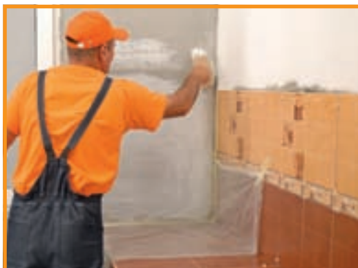
12. Un perete trebuia acoperit cu tencuială decorativă mozaicată, prin urmare a fost nevoie de o amorsă.
