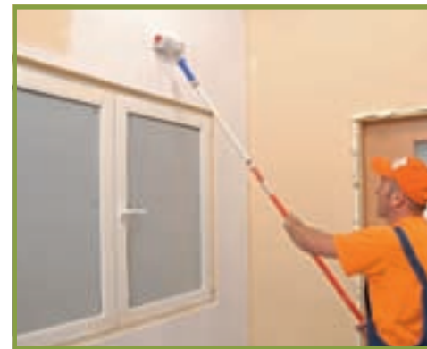
14. Amorsarea poate fi dificilă uneori, deci este permisă folosirea unui trafalet cu prelungitor.
