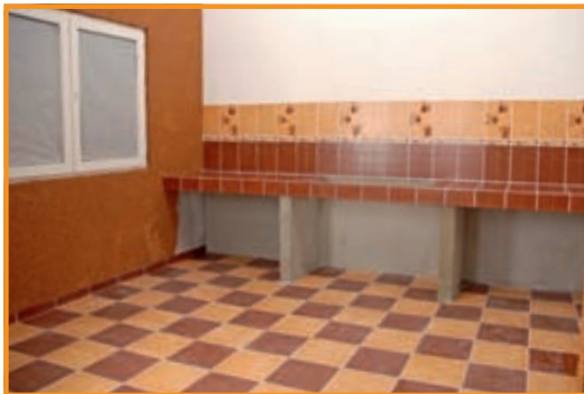
21. După cum vedeți, amorsarea a fost executată numai pe o suprafață limitată, zidul din stânga fiind acoperit deja cu tencuială decorativă.
