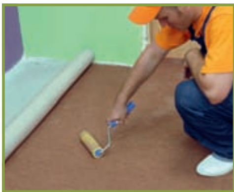
20. Pentru a elimina golurile de aer și orice altă eventuală imperfecțiune, s-a folosit rola de cauciuc.
