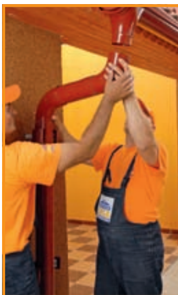
36. Acum se poate monta burlanul, la care s-au folosit coturi de 70°.
