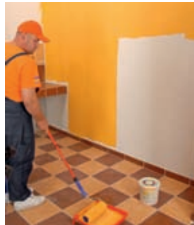
22. Peste grundul care a conferit peretelui un aspect mat, s-a aplicat vopsea lavabilă.
