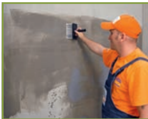
2. ... pereții au fost amorsați cu un produs având timpul de uscare redus: 4 ore de la aplicare.
