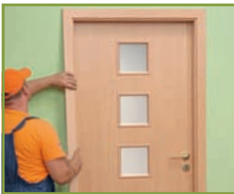
21. La final, pe tocul ușii se montează pervazele care au sisteme speciale de prindere.
