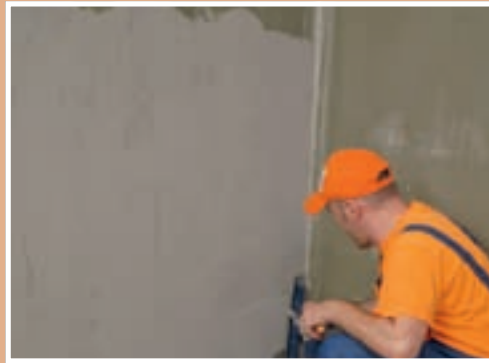
7. Acum se poate aplica și următorul strat de pastă, de grosimea specificată pe etichetă.
