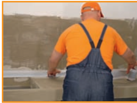
4. Suprafața a fost pregătită astfel și pentru hidroizolarea cu o pastă flexibilă, având rol protector pentru ziduri.
