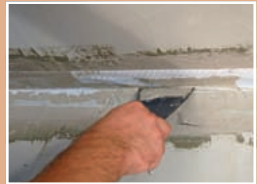
4. Banda cauciucată se înglobează în pastă cu ajutorul unui șpaclu.
