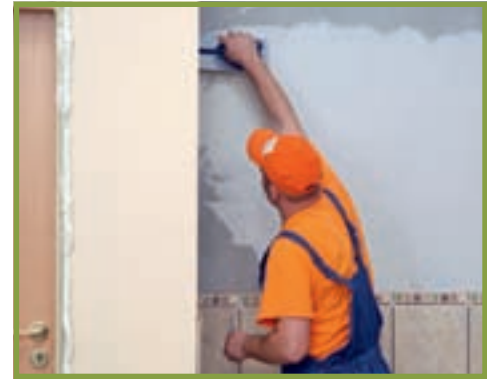
11. Partea superioară a pereților se poate finisa cu straturi de glet (primul cu rezistență la fisurare).
