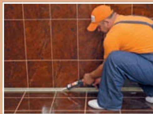
4. Colțurile se pot proteja suplimentar cu silicon sanitar, care izolează împotriva infiltrațiilor.
