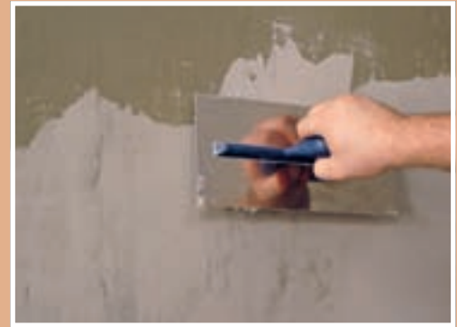
8. De această dată, se poate folosi gletiera. Astfel, textura peretelui va fi mult mai fină.
