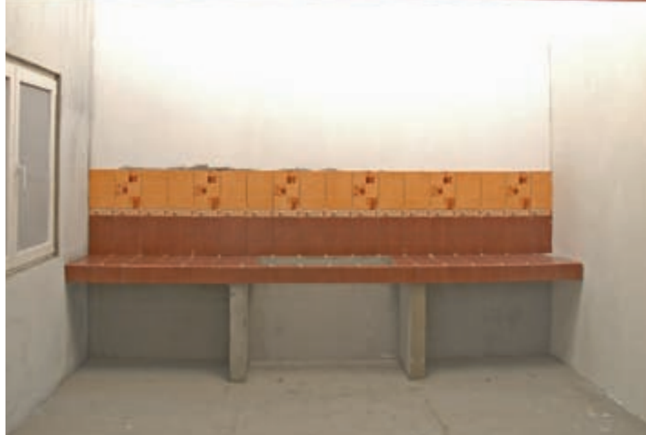
8. Timp de 2 ore, cât se uscă hidroizolația, s-a putut gleui porțiunea aferentă, care va fi vopsită ulterior.
