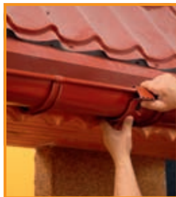
32. ... se folosesc elemente de îmbinare metalice, ce conferă rezistență.
