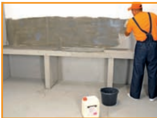
1. În zona unde se va instala chiuveta și blatul, am amorsat peretele cu un grund de profunzime...
