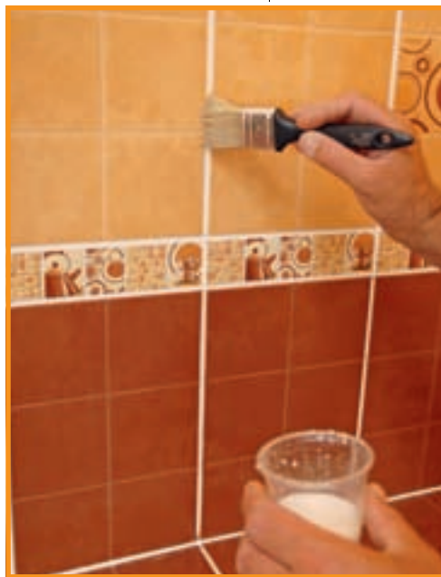
39. Nu strică să aplicăm și un strat de lac pentru chi-turi de rost, un produs transparent, fără solvenți.
