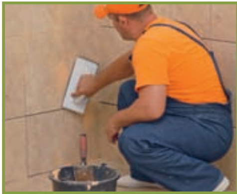
15. În același timp, un alt meseriaș a putut finaliza acoperirea cu faianță și a chituit întreaga placare.
