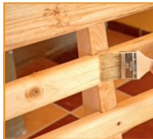
41. Ultimele finisaje au vizat mobilierul din lemn masiv, care a fost protejat cu un grund și o lazură transparentă.
