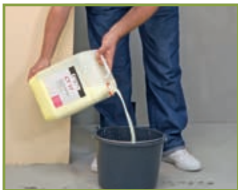
1. Pentru stabilizarea și reducerea absorbabilității suportului în zonele unde vor fi placări ceramice...
