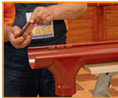
28. Capetele de jgheab au fost prevăzute cu garnituri care previn scurgerea necontrolată a apei.
