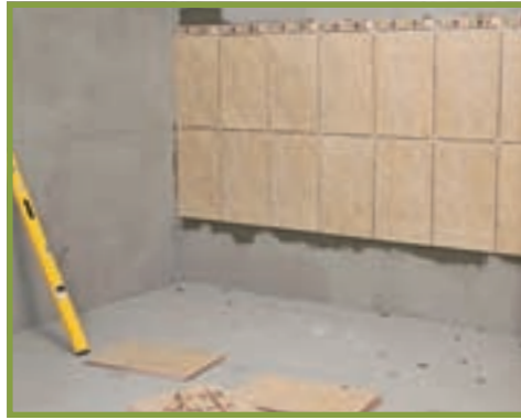
10. Placarea a început de la o cotă stabilită deasupra pardoselii, după axe verticală și orizontală.
