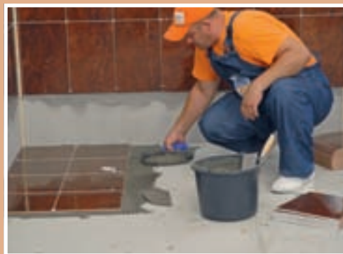
1. Pentru montarea gresiei, folosim un adeziv flexibil, (ca la faianță), ce poate fi utilizat și la exterior.
