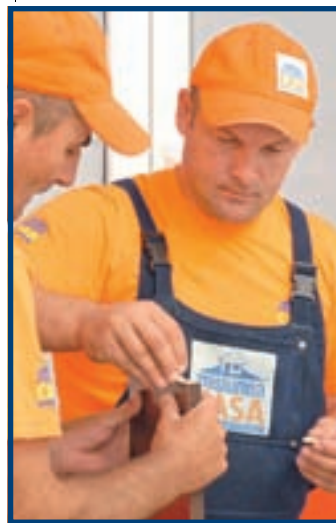
4 Diblurile se introduc după ce au fost îmbibate în adezivul special pentru lemn.
