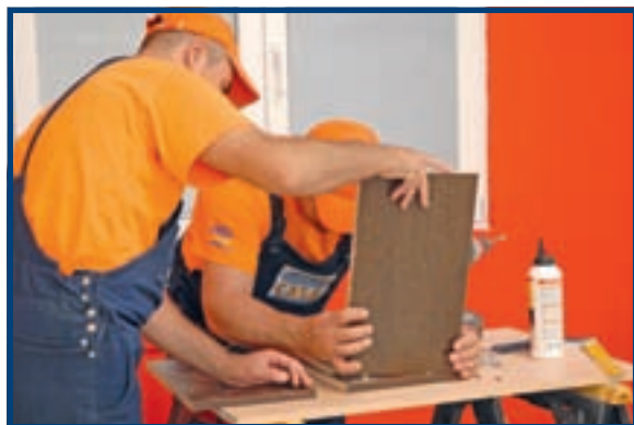
6 Am ajuns la primul test de „fidelitate“ a măsurătorilor. Adezivul poate fi aplicat și prin introducerea în găuri.
