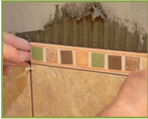
9. Marginea superioară a zonei de faianță a fost delimitată de un brâu îngust fin din același material.
