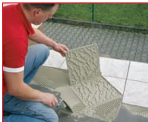
23. Iată concret care e efectul procedurii speciale de aplicare a adezivului: el continuă atât pe gresie cât și pe suprafața balconului, fără a lipsi din vreun loc.
