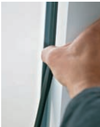
17. Și elementul de etanșare (chederul) e reasezat la loc. Pentru a-l fixa mai ușor, tratați-l în prealabil cu silicon sau leșie de săpun.
