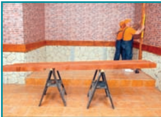
23. Dacă vopseaua de pe grinzi s-a uscat, puteți începe fixarea acestora în găurile realizate în prealabil.
