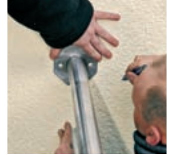
20 ... respectiv în zidul dinspre grădină. Se folosesc două bolțuri de ancorare la fiecare rozetă.
