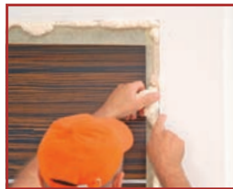
17. Se va lucra cu atenție, pentru a evita zgârierea furnirului ușii sau a tocului de care este fixată.
