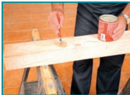
20. Înainte de a fi montate grinzile aparente din lemn, acestea vor trebui acoperite cu grund și lac.
