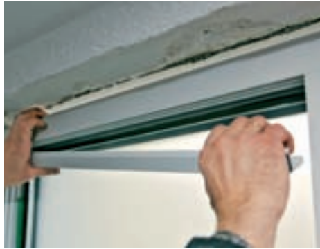
8. Riglele de fixare a geamului sunt asamblate printr-un sistem special cu clichet și astfel pot fi demontate foarte ușor.
