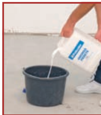
20. Pentru amorsarea pereților se folosește un grund de profunzime.
