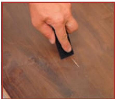
32. Surplusul de adeziv trebuie curățat după întărire, cu ajutorul unei soluții speciale.
