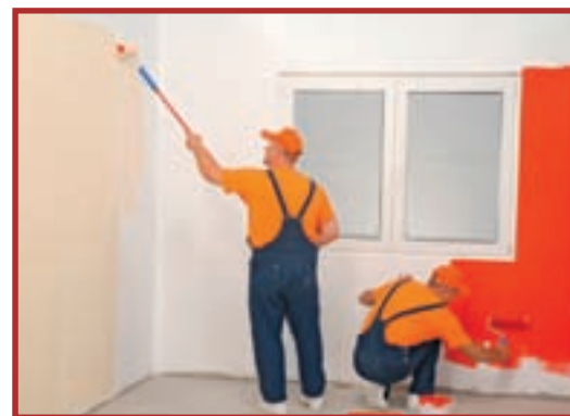
24. Pentru aplicarea vopselei vor fi utilizate trafalete diferite, câte unul pentru fiecare culoare.
