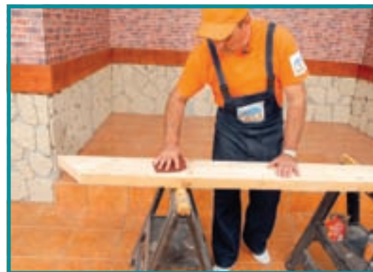
21. După fiecare grunduire, este indicat să se șlefuiască suprafața cu hârtie abrazivă.
