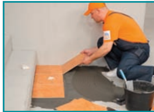
13. Din cauza condițiilor specifice unui subsol, se folosește un adeziv cu o rezistență mai mare la umezeală.
