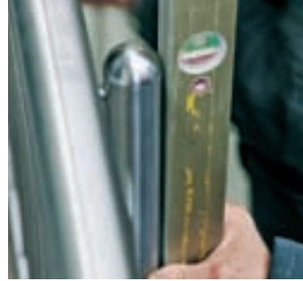
19. Balustrada executată integral în fabrică e pozată riguros și apoi fixată pe latura exterioară a scării...
