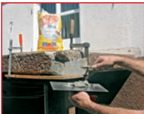
4. Apoi sunt remediate rapid colțurile deteriorate ale plăcii balconului. O scândură fixată dedesubt în menghine servește ca suport pentru mortar.
