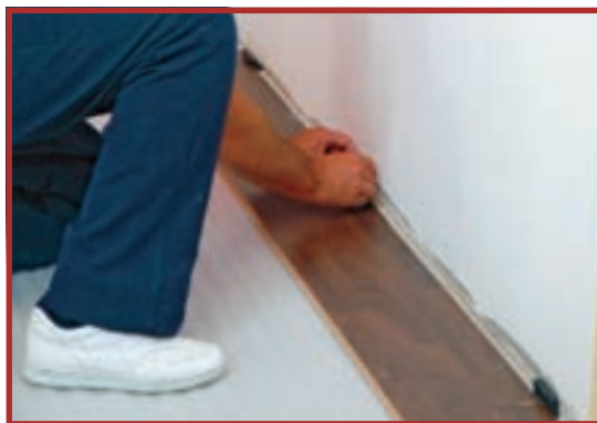
27. Urmează montarea parchetului. După ce aplicați folia izolatoare și fixați un distanțier până la perete...
