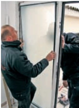
14. Acum e repusă la loc pe cleme și foaia de geam a panoului lateral...
