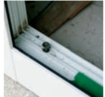
13. Abia apoi sunt executate și celelalte găuri pentru dibluri, în vederea montării definitive a ramelor în perete, respectiv pardoseală.
