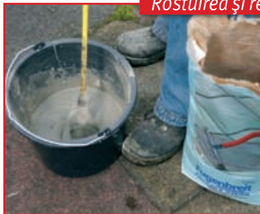
25. Materialul de rostuire trebuie să fie la fel de flexibil ca adezivul. El va fi mixat conform procedurii explicat, rezultând un amestec nici prea diluat, nici prea gros.
