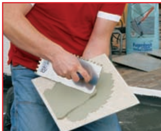
21. Toate plăcile de gresie (inclusiv cele marginale) trebuie montate printr-o procedură specială, ce presupune aplicarea mortarului și pe partea lor inferioară.
