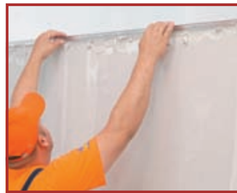
9. E bine ca elementele metalice (colțarele) să nu fie tensionate, chiar dacă liniile nu sunt drepte.
