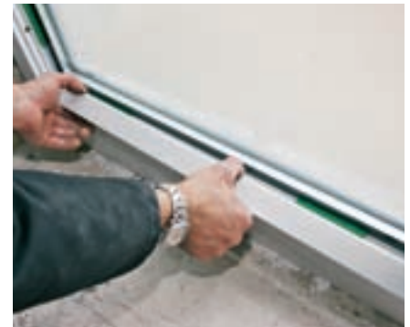
16. E momentul să fie montate din nou riglele de fixare a geamului, întâi cele orizontale și, la final, cele verticale.
