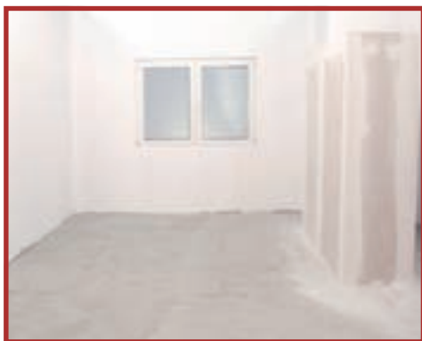
11. Odată finalizată prelucrarea marginilor construcției din gips-carton, se va aștepta uscarea gletului.
