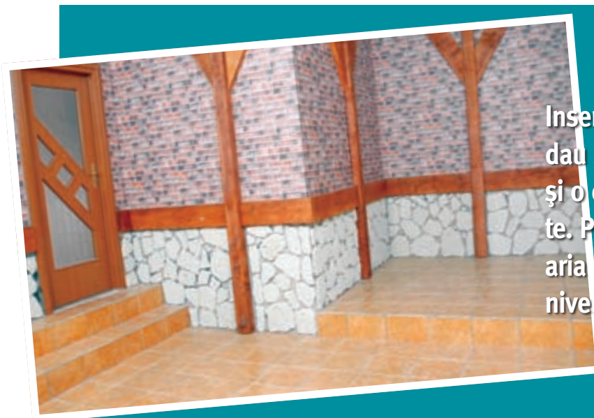
20. Înainte de a fi montate grinzile aparente din lemn, acestea vor trebui acoperite cu grund și lac.
