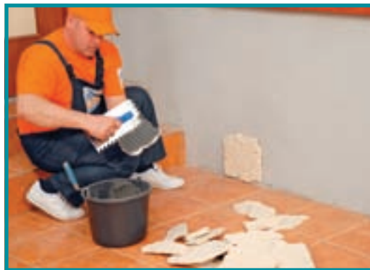
17. În zona inferioară a peretelui, unde în prealabil am realizat hidroizolația, am ales să placăm cu piatră.
