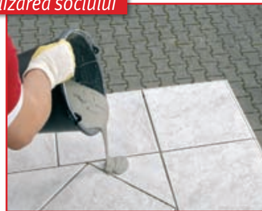
26. Apoi masa de rostuire va fi turnată aproximativ astfel. La plăcile din exterior sau în cazul alegerii unor formate mai mari, rosturile pot fi chiar mai late.
