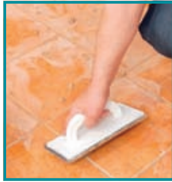
15. Pentru chituire, am folosit, ca de obicei, o gletieră de cauciuc. Evitați rosturile concave în acest spațiu!
