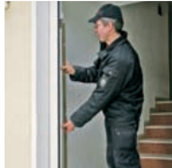
12. Înainte de a fixa cadrul și în partea de jos, se verifică încă o dată poziția lui verticală, corectând-o în caz de nevoie.
