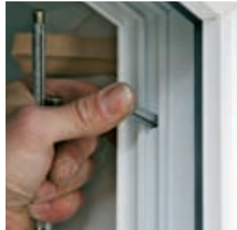
11 ... realizează montajul propriu-zis, introducând diblurile în găurile executate cu un burghiu pentru piatră și înșurubându-le ferm.
