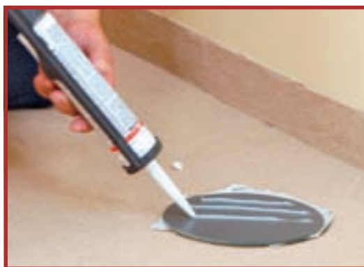
25. La lipirea unor bucăți de oglindă de formă circulară se folosește un silicon neutral.
