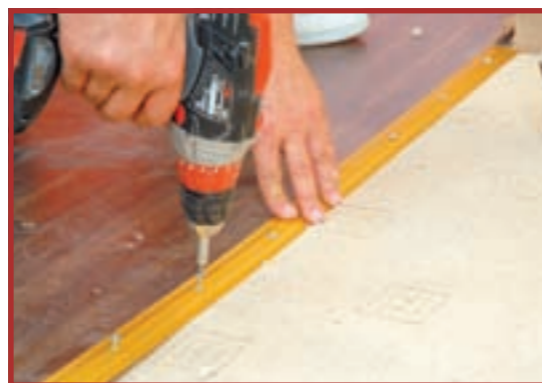
40. În ultima etapă vor fi montate pragurile folosindu-se o mașină de găurit și înfiletat, cu acumulator.
