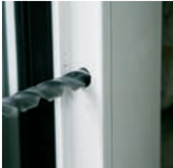
10. Cu un burghiu de 10 mm pentru metale sunt practicate găuri în punctele trasate anterior pe montantul aferent ușii. Apoi, specialiștii...
