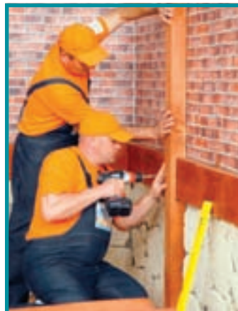
24. Verticalita- tea grinzilor trebuie verifi- cată cu instru- mente adecva- te. Astfel pu- tem evita un montaj defec- tuos ce ar pu- tea strica as- pectul general.
