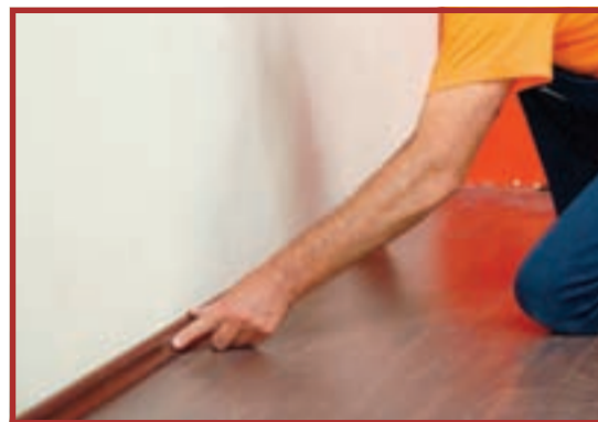
34. Conform sfaturilor specialiștilor, profilele de margine trebuie fixate de parchet, nicidecum de perete.
