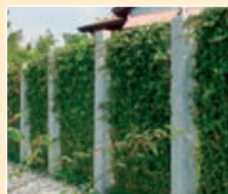
sau o execuție mai distinsă: stele de granit drept stâlpi de montaj.
