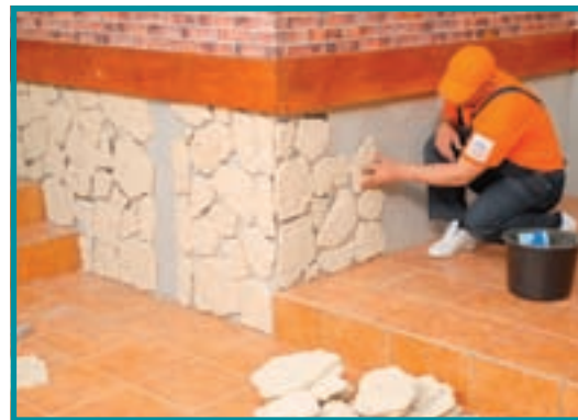
18. Rosturile neregulate, ce dau farmec amenajării, nu trebuie să fie prea late, chiar dacă sunt umplute cu chit.
