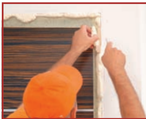
16. Montați și ușa! Fixați-o în șuruburi, aplicați spuma poliuretanică și îndepărtați surplusul întărit.
