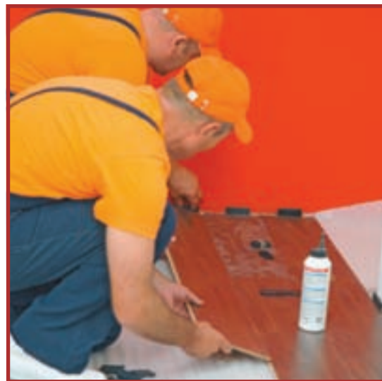
28. ... începeți asamblarea elementelor. Adezivul se aplică pe caneluri (este un sistem în nut și feder).
