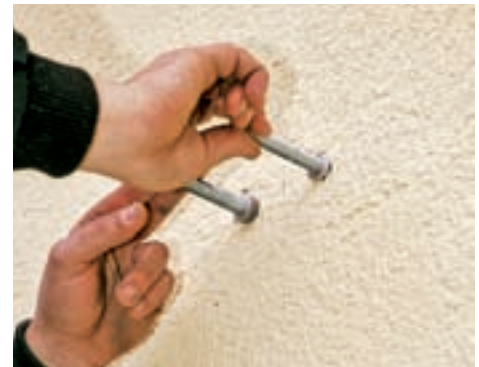
25. Piesele filetate de susținere sunt introduse în cele aderente. După fixarea lor, trebuie așteptat ca adezivul să se întărească complet.
