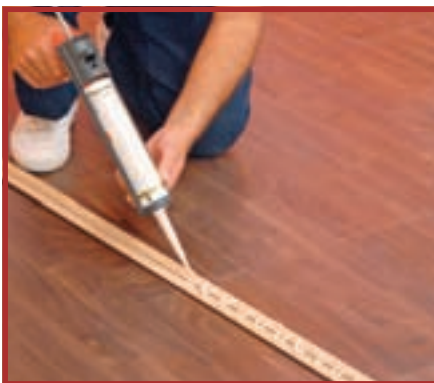
33. La plintă se folosește un adeziv care să lipească atât lemn cât și suprafețe sintetice.
