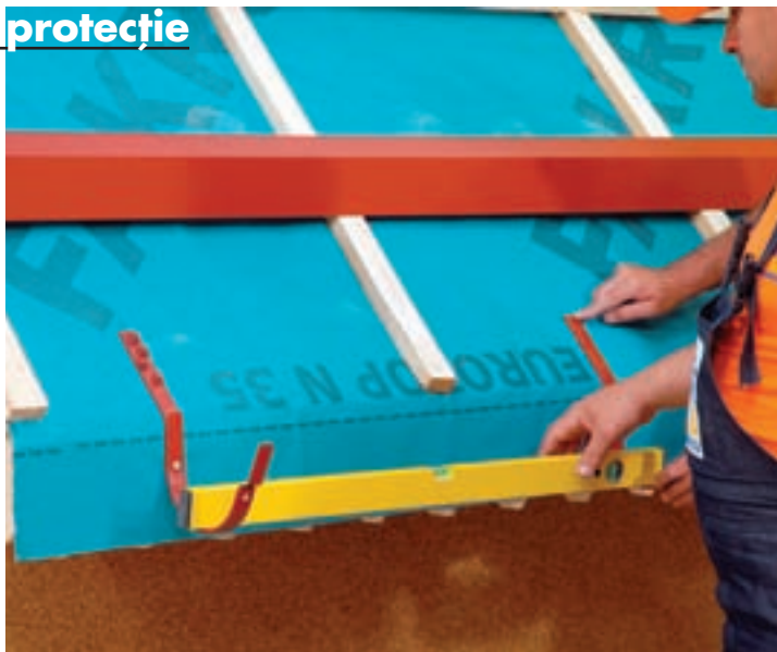
9. La fiecare două cârlige montate se verifică panta viitorului jgheab, cu o nivelă cu bulă. Dacă unghiul nu este destul de mare, în această fază încă se mai pot face corecții.
