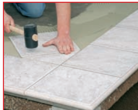
22. Acum începe dispunerea lor pe diagonală. Prima bucată de gresie este un triunghi dreptunghic, a cărui ipotenuză are exact lungimea laturii unei plăci întregi.
