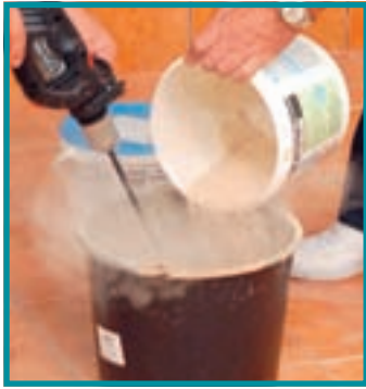
14. Și chitul va fi unul rezistent la umezeală. Am acordat atenție doza- jului și consistenței pastei rezultate.
