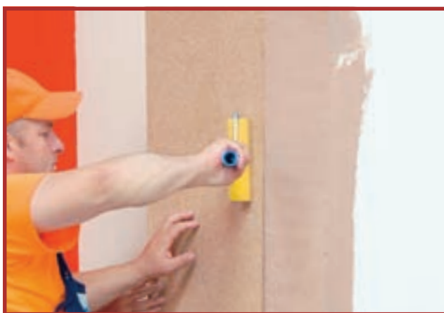
15. O rolă de cauciuc elimină golurile de aer prinse sub stratul de plută. Treceți cu instrumentul peste suprafața din centru spre exterior.
