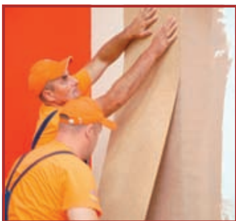
14. Pelicula de plută se va lipi de sus în jos. În cazul în care în zonă se află ceva care v-ar putea da o mână de ajutor, n-ar strica să-i cereți sprijinul.
