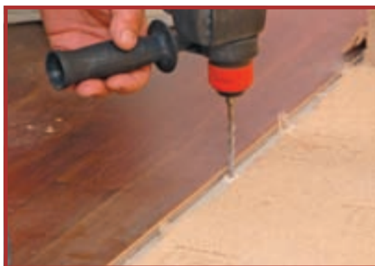
39. Executați găurile în pardoseală și introduceți diblurile, luând drept cotă finală suprafața exterioră a parchetului.
