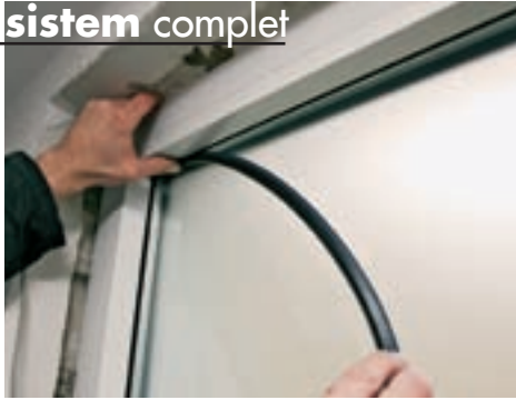
7. În continuare, au fost îndepărtate chederul perimetral, apoi riglele de fixare a geamului și clemele de susținere situate sub acestea.
