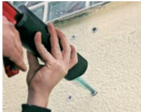
24. Apoi, specialiștii introduc diblurile aderente în găuri, umplându-le cu un adeziv cu două componente, pe bază de rășină epoxidică.
