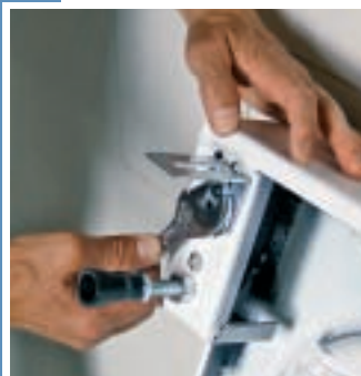
24. Înălțimea stabilită anterior va fi verificată perimetral (ulterior va fi montat dedesubt și soclul).
