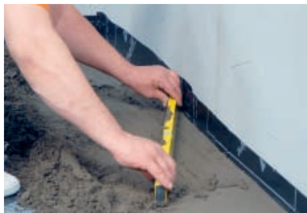
7. Nisipul se va egaliza - chiar cu ajutorul nivelei cu bulă - pentru a se obține o suprafață perfect plană. Ulterior, peste acest strat se va turna o șapă clasică.
