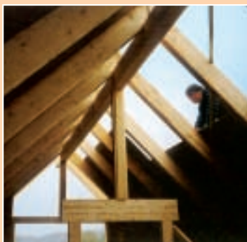
Finalizarea lucrărilor de la acoperiș a constat în aplicarea pe șarpantă a unor țigle de beton.
