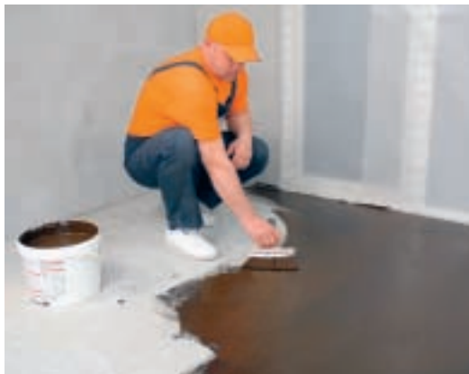
1. Pentru izolarea unei pardoseli de la exterior, se va aplica mai întâi un grund special, diluabil cu apă, pentru îmbunătățirea aderenței membranelor de etanșare.
