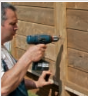
19. La sfârșit, au fost integrate în stâlpi niște spoturi cu leduri. În acest scop, trebuie practicate mai întâi niște locașuri, folosind burghiul de 30 mm...
