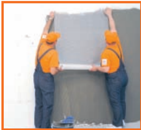
9. Imediat se va așeza plasa de armare a termoizolației. Această rețea va asigura un montaj mult mai rezistent și mai eficient.
