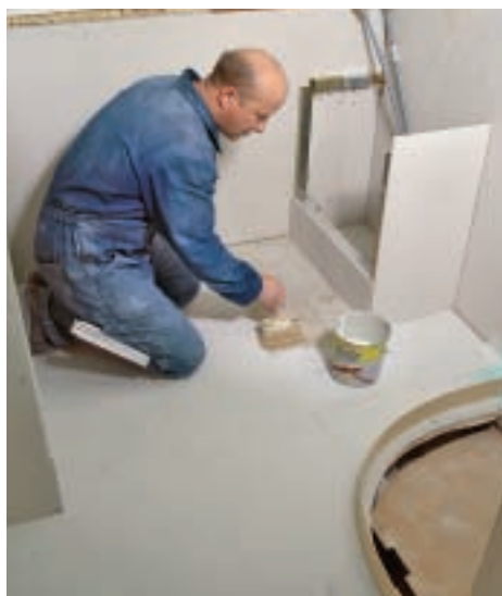
19. Toate suprafețele de pe pardoseală și perete ce trebuie placate sunt impregnate cu un grund de profunzime pentru îmbunătățirea aderenței.
