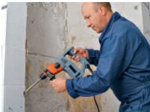
1. Renovare totală! Mai întâi, au fost demontate obiectele sanitare, apoi s-au îndepărtat plăcările interioare (precum faianța) folosind ciocanul rotopercutor cu daltă.
