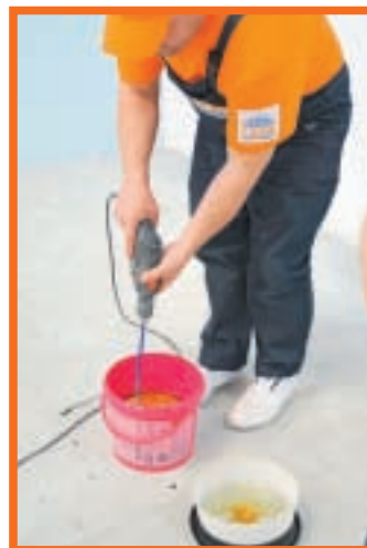
13. Deși piesele din lemn se îmbină în sistem nut – feder, mai întâi vom aplica un strat de adeziv pentru pardoseală din lemn. Soluția este bicomponentă, iar amestecarea se realizează în mod mecanic.
