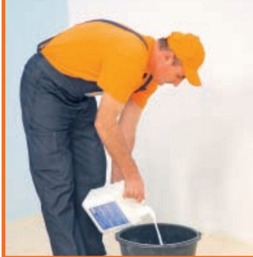
17. Gletul este perfect uscat, deci se poate trece la vopsirea pereților. Până atunci, însă, zidul trebuie amorsat cu grund pentru a crește aderența vopselei.
