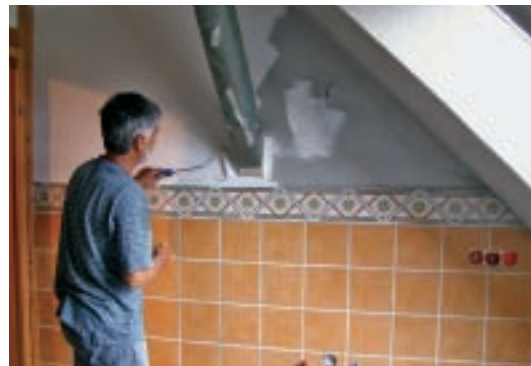
20. Ultima operațiune de finisare a pereților: peste tencuială a fost aplicată o vopsea albă în dispersie, ce conferă băii un aer luminos.
