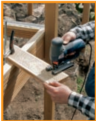
8. Realizarea pardoseli: fiind situat chiar în dreptul stâlpului, primul element trebuie mai întâi decupat...
