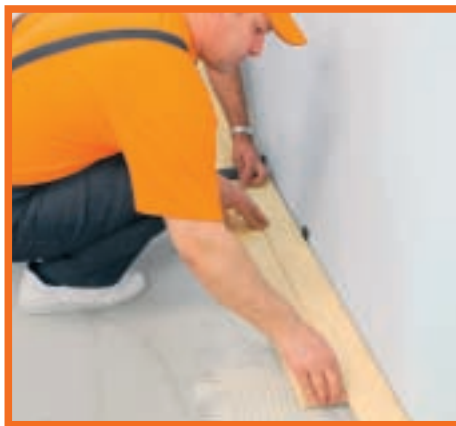
15. Placarea se începe din colțul opus ușii. Astfel, nu veți fi nevoit să călcați peste montajul proaspăt imediat după încheierea lucrării.
