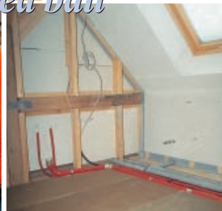
4. Vedere spre zona lavoarelor. Sunt deja finalizate placarea suprafețelor și instalarea țevilor de apă și încălzire.
