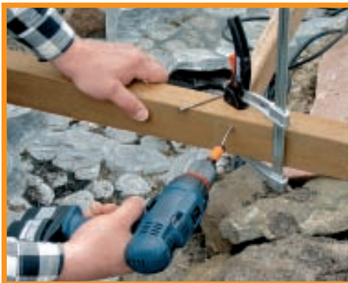
4. Riglele transversale trebuie înșurubate în cadrul din lemn fără vreun sistem de îmbinare a elementelor constructive. De aceea, ele au fost strânse cu o menghină.
