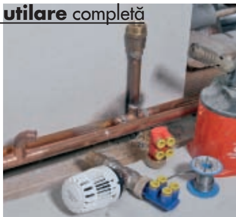
15. Baia a fost dotată și cu o instalație de încălzire prin pardoseală, fiind realizată o derivație de la turul și returul circuitului încălzirii centrale.
