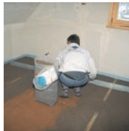
5. Pe plăcile fonoizolatoare se aplică acum la înălțimea dorită un strat intermediar cu rol de egalizare.
