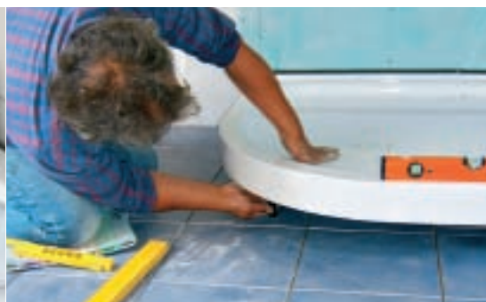
27. Pentru fixarea soclului executat din oțel emailat, sub partea de jos a cuvei trebuie montate mai întâi corniere corespunzătoare. Montajul este ascuns vederii, iar soclul poate fi detașat.
