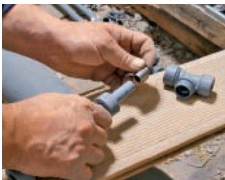
6. Eventualele bavuri rămase trebuie îndepărtate. Abia apoi se introduce în capătul țevii un ștuț de susținere din oțel superior.
