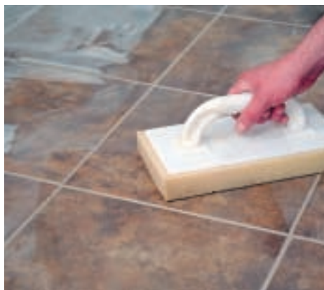
19. Chitul se va îndepărta cu ajutorul gletierei cu burete. Buretele va fi umed și se va spăla des pentru a obține o suprafață îndeajuns de curată.
