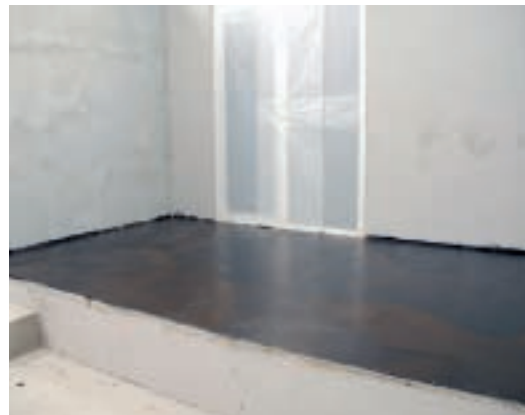
2. Emulsia trebuie aplicată uniform, pe suprafețe curate și uscate, la o temperatură de cel puțin -5°C. Substanța se usucă repede, prin urmare puteți trece mai departe.
