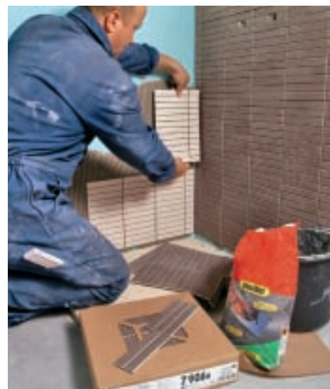
20. Plăcile de faianță vor fi aplicate pe un pat subțire de adeziv flexibil. Întindeți adezivul, nivelați-l cu gletiera cu dinți, apoi așezați plăcile.
