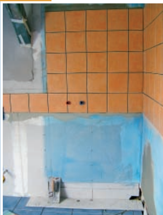
12. Pe suprafețele verticale rezervate dușului, faianța a fost aplicată până aproape de tavan (ca protecție împotriva stropilor de apă).
