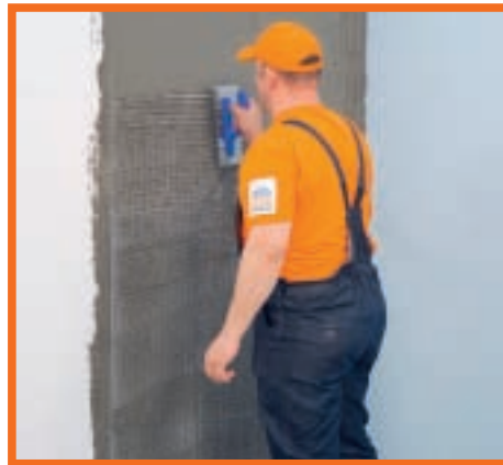
10. Pentru fixarea plasei, se va aplica un nou strat de adeziv. Acesta va garanta practic încheierea cu succes a operațiunii de termoizolare.
