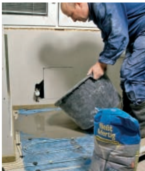
18. Acum se toarnă pe pardoseală o masă de egalizare autonivelantă. Înălțimea instalației de încălzire plus stratul de nivelare ajung la 10 cm.
