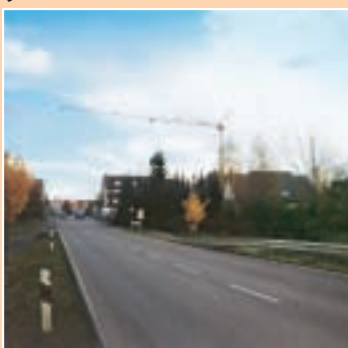
Macaraua e un reper de localizare a șantierului: în imediata apropiere a unui drum național intens circulat.
