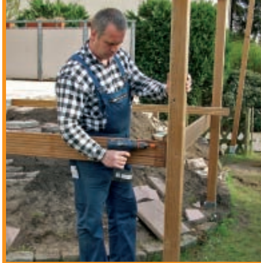
2. Stâlpii au fost introduși în manșoanele de oțel ale piloților. Două rame din lemn asamblate împreună, prin corniere, au fost fixate apoi cu șuruburi.
