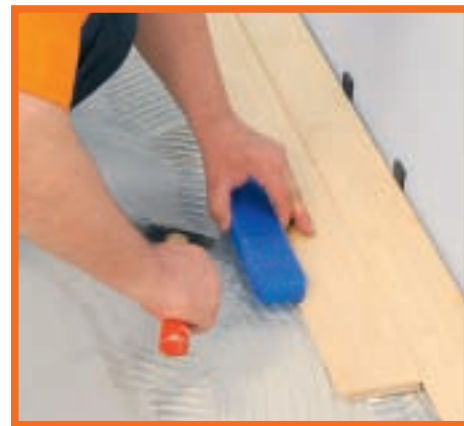
16. Fixarea eficientă a pieselor din lemn se va realiza cu ajutorul ciocanului. Folosiți un element tampon pentru a nu deteriora lemnul.
