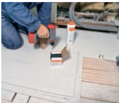
10. Pardoseala va fi executată cu ajutorul unor elemente de șapă uscată. Acestea trebuie lipite între ele și fixate decalat cu șuruburi pe linia falțului.
