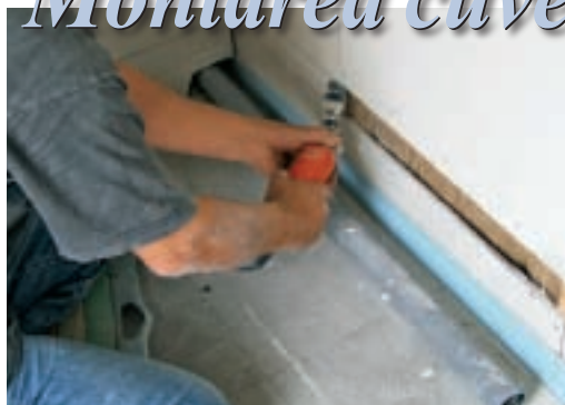
22. În plăcile din gips-carton se debitează un locaș lat, la cota de nivel a marginii superioare a cuvei. Pentru aceasta, vă sfătuim să folosiți o sculă specială de tăiere.
