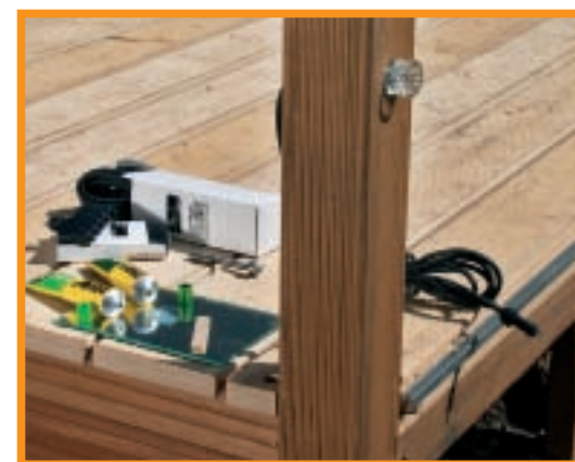
20. ... în care urmează să fie fixate spoturile, cu ajutorul unui adeziv cu două componente. Acum mai rămâne doar să cablați corpurile de iluminat la transformator.
