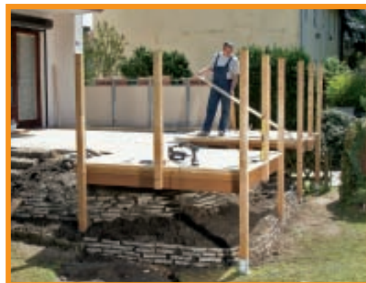
11. Soluția adoptată pentru montanți permite suspendarea ambelor platforme peste taluz, fără ca acestea să necesite în vreun fel spațiu suplimentar.
