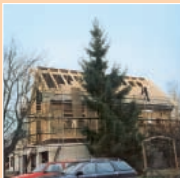
Unul dintre dezideratele execuției viza ca partea supraetajată să nu fie mai înaltă decât clădirea existentă.
