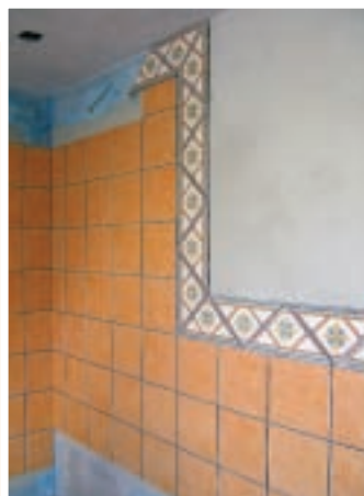
13. Înaintea aplicării rândurilor de faianță de la paza pereților, trebuie amplasată cuva dușului, înglobând rebordul (vezi și pasul 22).
