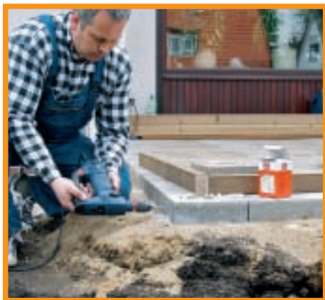
5. Pentru a fixa structura nou creată de vechea terasă, au fost folosite, pe partea frontală a plăcilor, o serie de dibluri și rame din lemn.
