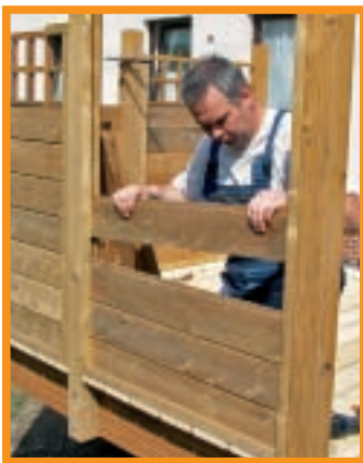
14. ... în care s-au introdus prin partea superioară scânduri de obturare (cu nutul în jos – altminteri apa pluvială va stagna în el).
