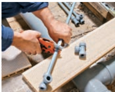
5. Țevile din polibutilenă trebuie tăiate cu grijă, perpendicular pe marcasele stabilite în prealabil, folosind o foarfecă specială.
