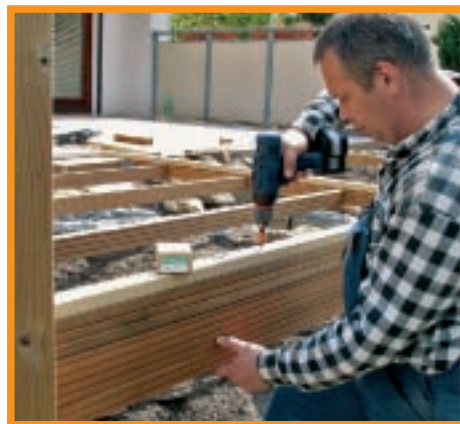
7. Elementele de rezistență au fost aliniate la nivel și înșurubate de cadrul noii structuri. În același fel, au fost dublate și riglele transversale.
