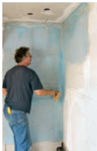
9. În colțul dușului, plăcile din gips-carton au fost tratate cu un grund de acoperire hidrofoab.
