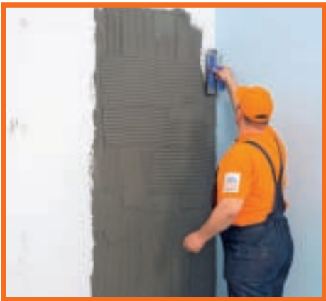
8. După ce v-ați asigurat că polistirenul a aderat cu succes la suprafața zidului, puteți continua cu încă un strat de adeziv peste acesta.
