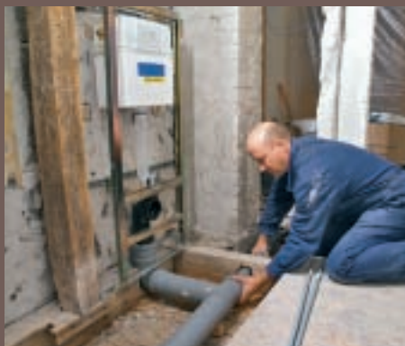
3. E momentul stabilirii traseului conductei principale de canalizare. Ea va fi amplasată în pantă, în spațiul gol al planșeului intermediar.
