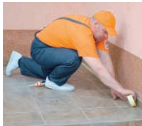
20. Pentru a ușura aplicarea siliconului ce va izola rosturile formate între plintă și gresie, se vor aplica două fâșii de bandă adezivă cu spațiu între ele.
