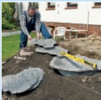
3. Acum pot fi așezate formele speciale aferente albiei pâraiașului. Ele trebuie poziționate corect.
