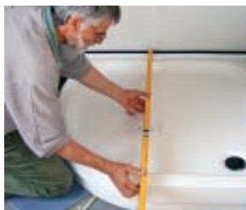
21. Se fac lucrări pregătitoare pentru racordarea la perete a cuvei dușului. Soclul este amplasat provizoriu.
