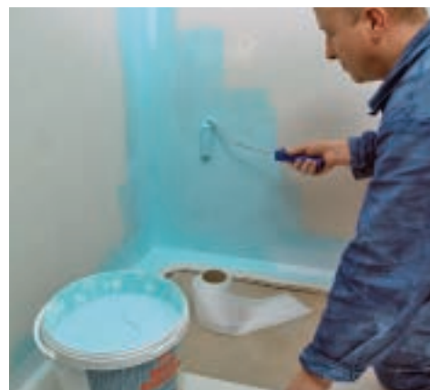
14. Pe întreaga zonă expusă stropilor de apă, va fi aplicată o soluție fluidă de etanșare. În colțuri, trebuie fixată suplimentar și bandă de etanșare.
