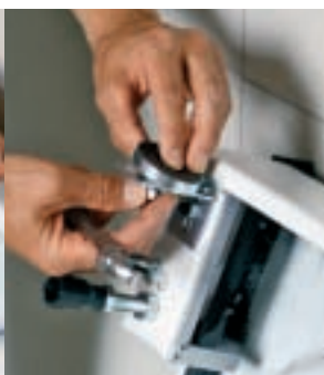
27. Pentru fixarea soclului executat din oțel emailat, sub partea de jos a cuvei trebuie montate mai întâi corniere corespunzătoare. Montajul este ascuns vederii, iar soclul poate fi detașat.
