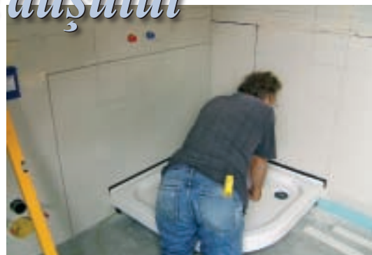
23. Cuva dușului va fi introdusă în deschiderile practicate pe ambele părți în perete. După eventuale ajustări, ea va fi amplasată definitiv.
