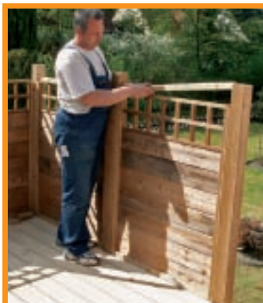
15. Sus au fost montate grilaje decorative în formă de pătrate succesive, deasupra cărora au fost fixate profile în „U”.
