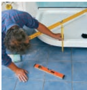
24. Înălțimea stabilită anterior va fi verificată perimetral (ulterior va fi montat dedesubt și soclul).
