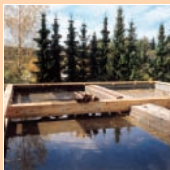
Structura de bază a acoperișului tip terasă al garajului constituie temelia noii case supraetajate din lemn.
