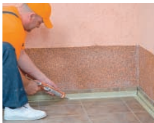
20. Pentru a ușura aplicarea siliconului ce va izola rosturile formate între plintă și gresie, se vor aplica două fâșii de bandă adezivă cu spațiu între ele.
