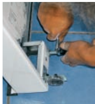
26. Se vor fixa și picioarele reglabile, ajustându-le la înălțimea finală a cuvei.
