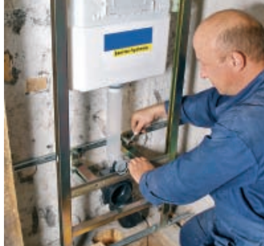
2. Lucrările încep prin montarea modului de perete autoportant aferent componentelor WC-ului. Acesta e fixat de un profil atașat anterior în peretele încăperii.
