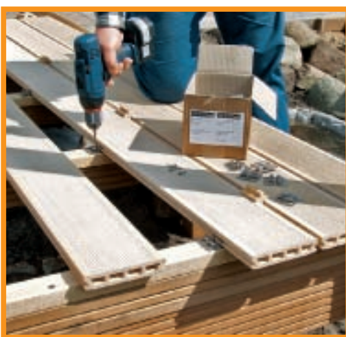
6. La montarea pardoseli propriu-zise, s-au ajustat întâi elementele de rezistență, ele fiind debitate apoi pe lungime cu ferăstrăul pendular.
