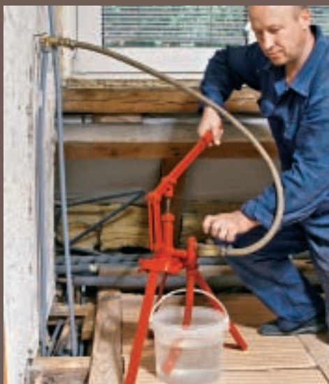
8. După încheierea montajului sistemului de conducte, se va efectua o verificare a presiunii recurgând la ajutorul unei pompe de refulare.
