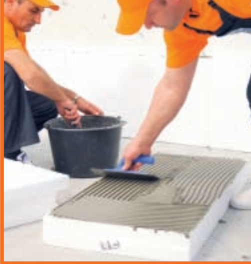
4. Aplicarea adezivului pe plăcile de polistiren se va face cu gletiera metalică. Pentru o priză mai bună, aplica-se va efectua pe mai multe direcții.
