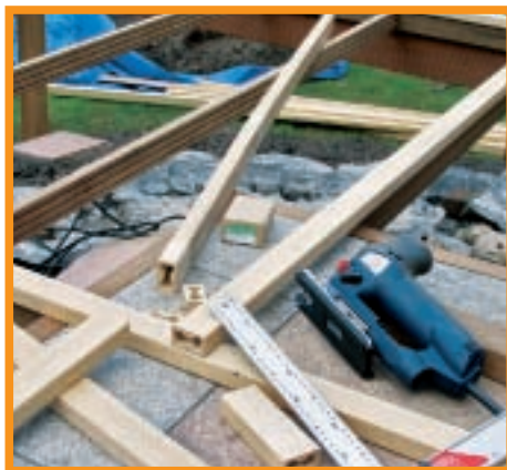
6. La montarea pardoseli propriu-zise, s-au ajustat întâi elementele de rezistență, ele fiind debitate apoi pe lungime cu ferăstrăul pendular.
