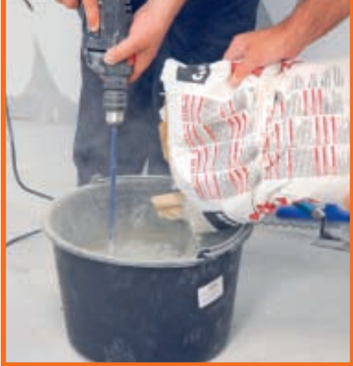
3. Adezivul (sub formă de pulbere) se va amesteca (mecanic) cu apă, în cantitatea necesară, până când acesta devine o pastă omogenă.
