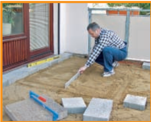
17. Pentru a putea așeza lespezile așa încât să rezulte o pantă ușoară a pardoselii, patul de nisip trebuie nivelat cu un dreptar ce glisează peste două bare metalice rotunde.
