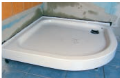
13. Înaintea aplicării rândurilor de faianță de la paza pereților, trebuie amplasată cuva dușului, înglobând rebordul (vezi și pasul 22).
