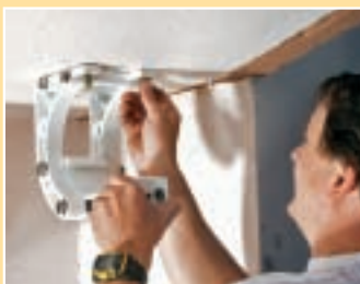
1. Ambele suporturi trebuie ajustate exact și fixate în partea de sus în ancoraje foarte rezistente.
