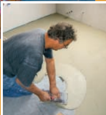
8. Înaintea aplicării gresiei, micile neuniformități ale șapei au fost egalizate cu o masă de șpaclu.
