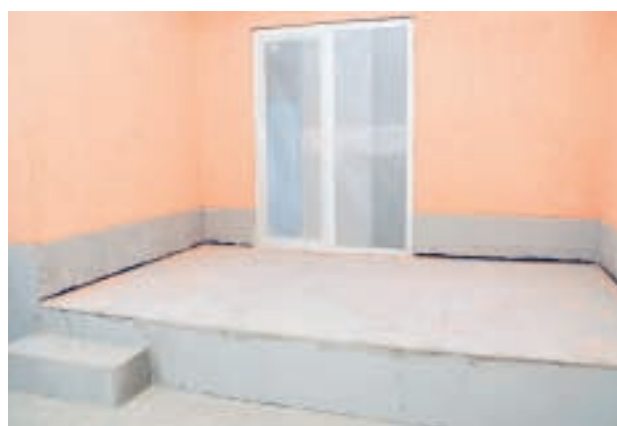
11. Cel mai indicat este să tencuiți toată suprafața delimitată într-o singură etapă, dřișcuiind-o. Grosimea stratului nu va depăși granulația nisipului din material.
