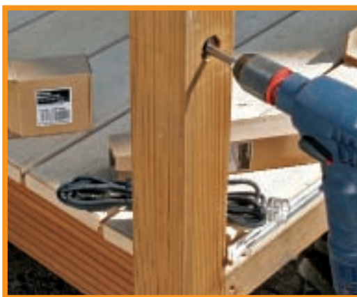
19. La sfârșit, au fost integrate în stâlpi niște spoturi cu leduri. În acest scop, trebuie practicate mai întâi niște locașuri, folosind burghiul de 30 mm...
