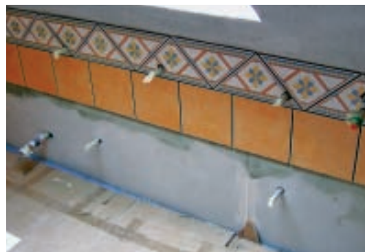
18. Elementele decorative pot fi aplicate și sub panta acoperișului. Străpungerile pentru țevile de încălzire și consolele portante au fost realizate cu o bormașină.
