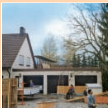
Situația reală de la fața locului: pe pereții portanți existenți ai garajului, trebuia ridicată o casă.
