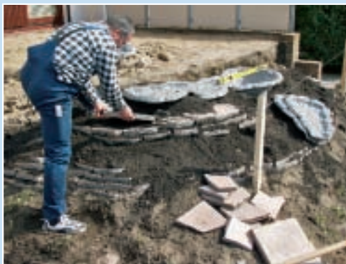
1. Pentru a putea realiza albia pâraiașului, au fost necesare lucrări de terasament și de nivelare a solului.
