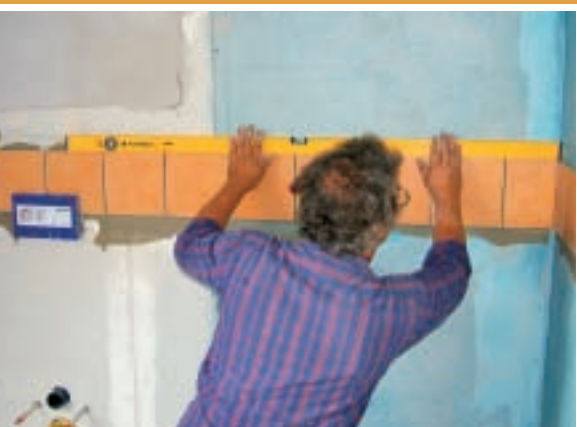
11. Cu excepția dușului, pereții au fost placați cu faianță doar până la jumătatea înălțimii lor. Mai întâi se aplică rândul de pe linia mediană, acesta fiind continuat apoi până în colțul dușului.
