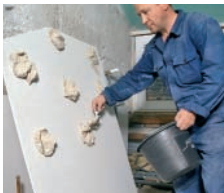
9. Pereții vor fi placați cu panouri de gips-carton: după aplicarea adezivului, pe partea din spate a plăcilor, se fixează prin lovire ușoară.
