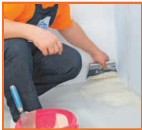
14. Numai după ce ați asigurat omogenitatea pastei obținute prin combinarea celor două componente, puteți aplica adezivul.
