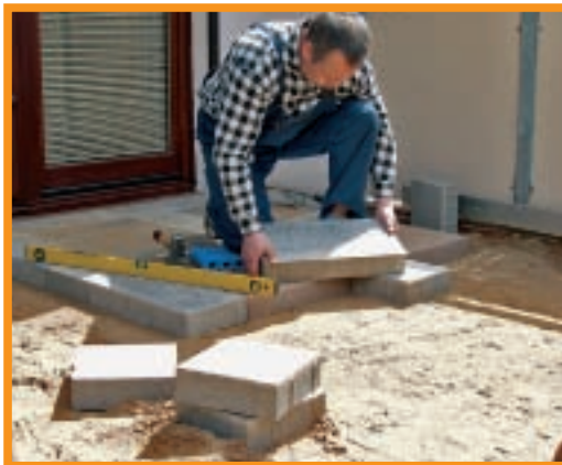
18. Acum poate începe aplicarea plăcilor. Nivelă cu bulă de aer asigură controlul permanent al pantei calculate în prealabil pentru dispunerea lespezilor.
