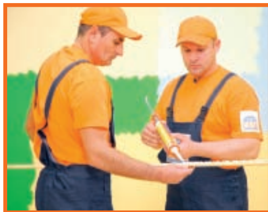
21. Dacă ați încheiat atât placarea pardoselii, cât și vopsirea pereților, va trebui să montați și plinta. Aceasta se va fixa cu ajutorul unui adeziv corespunzător.
