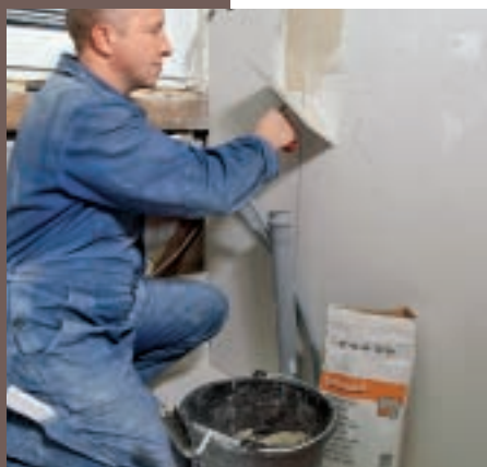
13. Urmează fixarea unor plăci de gips-carton pe structura metalică a peretelui. La sfârșit, rosturile dintre acestea vor fi spăcluite.
