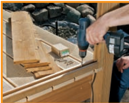
13. Acum se poate asambla paravanul. Pentru început, pe elementele de pardoseală și de-a lungul lateralelor stâlpilor au fost montate profile de ghidare...
