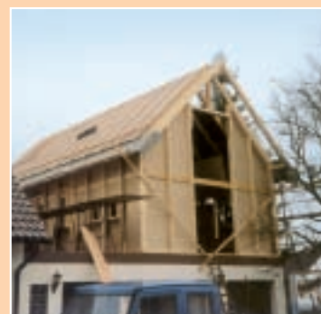
Progresul e rapid: folosind elemente prefabricate din lemn, primele rezultate sunt percepute în ritm accelerat.
