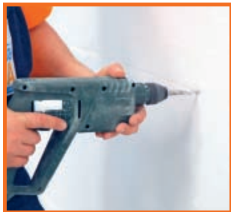
5. Plăcile de polistiren se vor asigura cu un sistem special pe bază de dibluri. Pentru aceasta, se vor realiza găuri în perete, din loc în loc.
