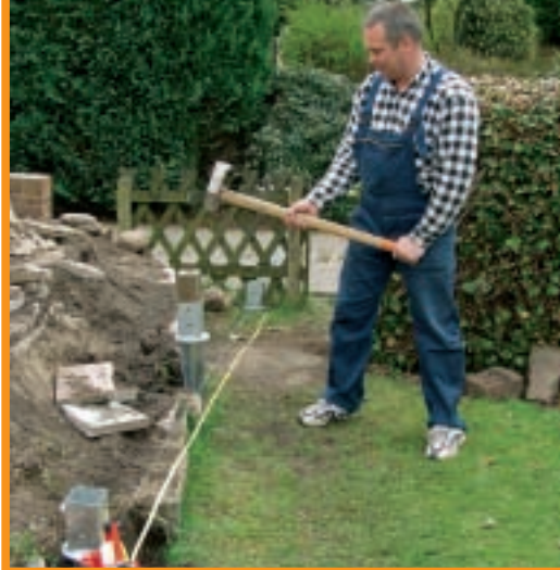
1. După delimitarea frontului de lucru, prin măsurători, și stabilirea locurilor de pozare a stâlpilor, s-au fixat piloții de fundație ai acestora prin bătăre în pământ.
