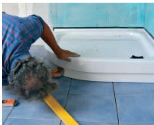
28. Cuva a fost potrivită exact pe înălțime, deci soclul va intra perfect sub ea. De remarcat că, astfel, s-a obținut un efect optic impecabil.
