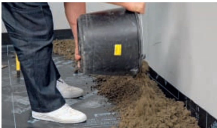
6. Pentru a se putea realiza o distribuție egală a sarcinii viitoarei pardoseli, peste hidroizolație se va adăuga un strat de nisip de râu. Această metodă asigură realizarea unor pardoseli rezistente la trafic mediu și greu.
