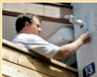
3. În final, urmează montarea și programarea sistemului mixt, cu senzori de vânt și ploaie.
