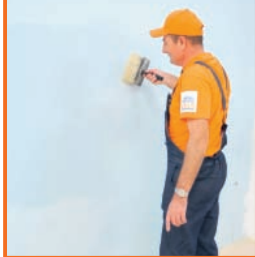
18. Amorsarea stratului-suport se va realiza cu ajutorul bidinelei. Cu cât operațiunea este mai bine efectuată, cu atât vopsirea se va face în mai puține straturi.
