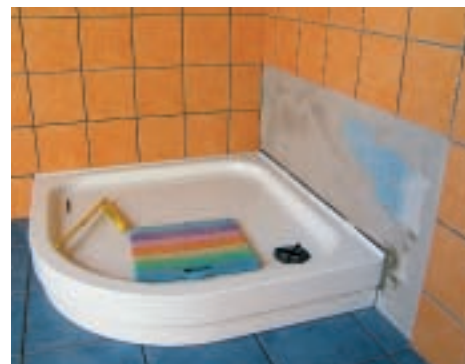
15. Astfel, între cuvă și perete va exista o continuitate, ce nu mai necesită o etanșare suplimentară cu silicon.
