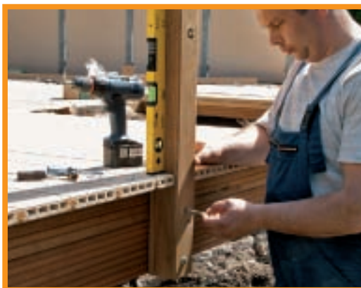
10. Este momentul asamblării montanților intermediari. Poziționați vertical, aceștia trebuie fixați cu șuruburi speciale pentru lemn de structura de susținere nou
