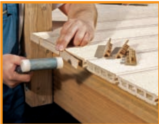
12. La capetele elementelor de pardoseală au fost montate capace de închidere. Rezultatul: o margine frumoasă, cu rol de protecție împotriva murdăriei și insectelor.
