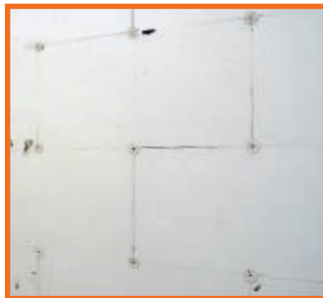
7. Diblurile se pot monta și la fiecare colț al unei plăci de polistiren. Dacă folosiți, însă, niște plăci de mari dimensiuni, vor fi mai dese.
