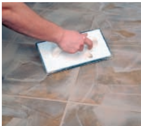
18. Urmează, în mod natural, chituiră plăcii de pe terasa dumneavoastră. Pentru aceasta se va folosi o gletieră din cauciuc.
