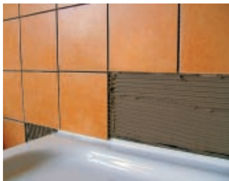
14. Ultimul rând de faianță trebuie să acopere rebordul cu circa 1 cm. Aici se vede bine spațiul liber dintre marginea emailată și faianță.
