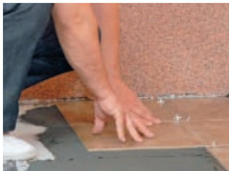
15. Cum, în acest interval, șapa turnată pe pardoseală a avut timp suficient să se întărească, este momentul să se monteze gresia.
