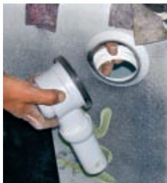
25. Acum cuva se va ridica din nou pe cant, pentru a putea monta adecvat scurgerea.
