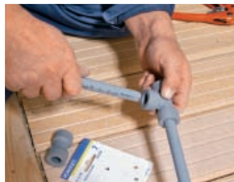
7. Acum vor fi îmbinate țevile cu fittingul monobloc, până la opritorul final. Pentru aceasta, trebuie depășite cele două faze de strângere.
