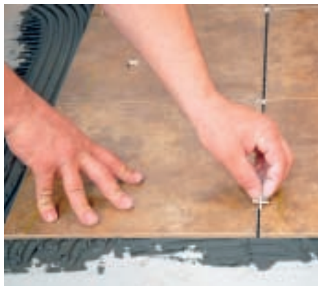
16. Distanțierile pe care le-ați folosit pentru a păstra rosturile de dilatație se vor extrage ulterior, înainte de chituire.
