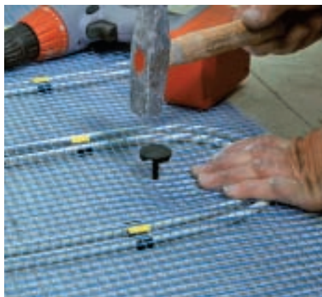
16. Plasa sudată pentru armare și elementele de încălzire trebuie așezate pe șapa uscată. Acestea se fixează în dibluri speciale cu capul plat.
