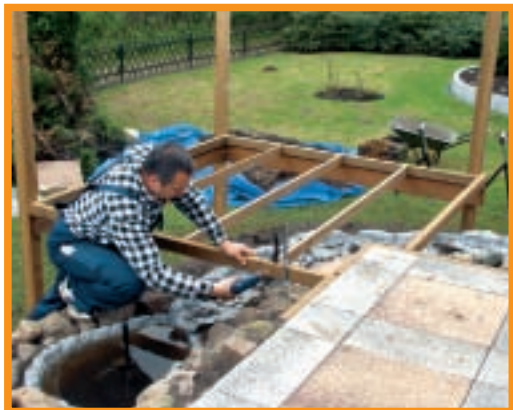
3. Pe aceste rame s-a montat un cadru pentru a uni structura nou creată cu terasa existentă. Acum sunt înșurubate câteva elemente transversale de rigidizare.
