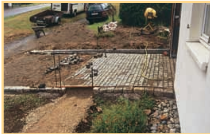
7. Pe suprafața pietruită, rosturile sunt dispuse transversal. O scândură provizorie delimitează această zonă de aleea de legătură cu intrarea principală.
