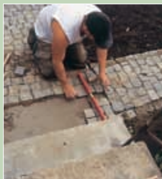
6. ... observa că sunt jumătăți, mai ales dacă vor fi dispuse la fel ca restul pavelelor, cu rosturi între ele.
