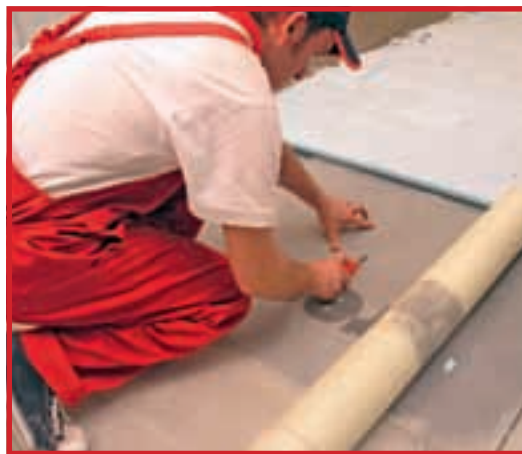
11. Decupați plasa de armare și aplicați-o în stratul de adeziv, înainte ca acesta să se întărească.
