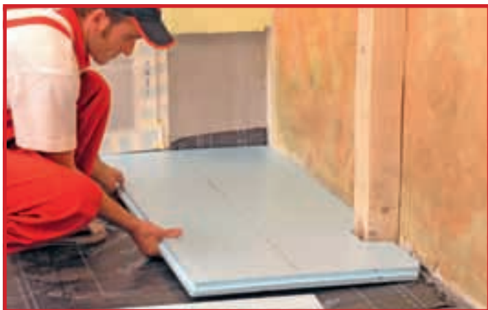
6. Încadrați plăcile cât mai bine în spațiul alocat, astfel încât punțile termice să fie eliminate în totalitate. Secretul constă într-o proiectare exactă.
