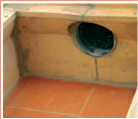
6. În continuare, s-au asamblat diferitele părți componente ale cuptorului propriu-zis. Elementele din șamotă au fost fixate cu un mortar special.
