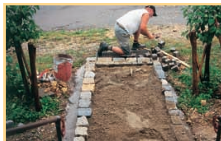
13. Abia după întărirea fundației de beton, pe care sunt așezate bordurile, pot fi aplicate celelalte pietre cubice, în șiruri paralele.
