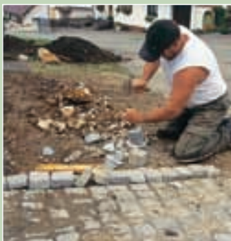
2. ... până la care trebuie să ajungă pavelele. Ele se debitează dintr-o piatră întregă, folosind o daltă.
