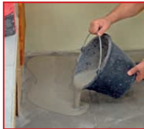
17. Termosistemul uscat în profunzime va fi acoperit cu o nouă șapă de egalizare, doar dacă este necesar.
