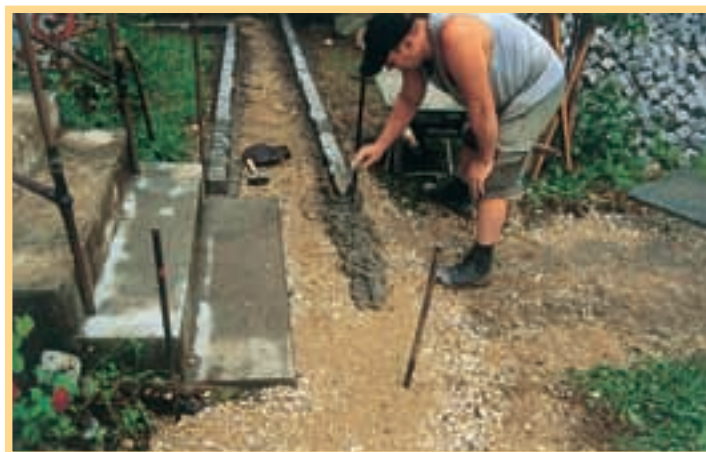
9. Aici, la ramificația din stânga scării, la fel ca și în situația anterioară, este executat mai întâi conturul aleii, cu borduri așezate într-o bandă de mortar.
