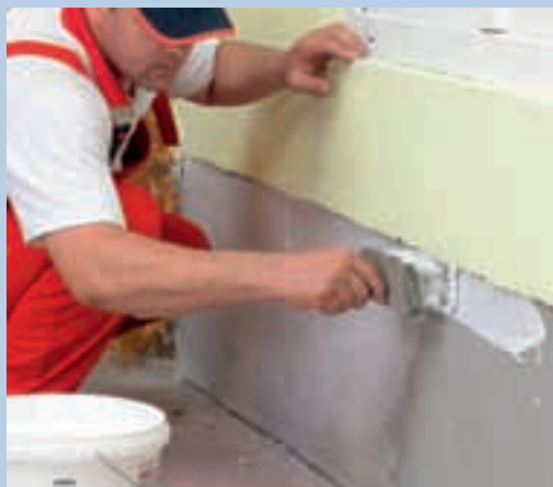
3. În etapa următoare, peste suprafața ce a fost lăsată să se usuce se va aplica un grund special.
