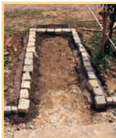
11. Iată cum pietrele mai mari alcătuiesc un contur exterior exact, în linie dreaptă.
