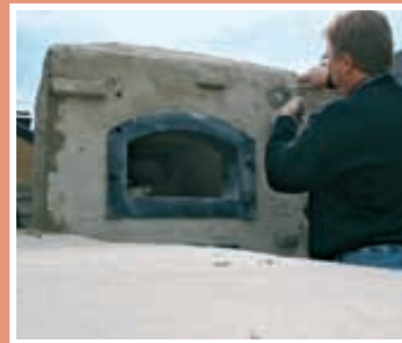
8. Pe corpul cuptorului au mai fost aplicate câteva bucăți de piatră cu rol decorativ, apoi un finisaj rustic, cu tencuiala specifică acestui stil.
