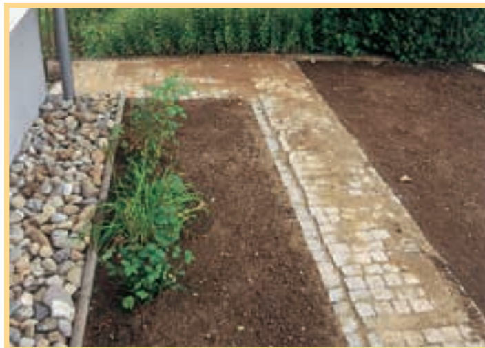
16. Aveți aici o imagine elocventă, chiar dacă aleea e încă în timpul fazei de execuție „la roșu”. Observați că pietrele n-au fost compactate până acum.
