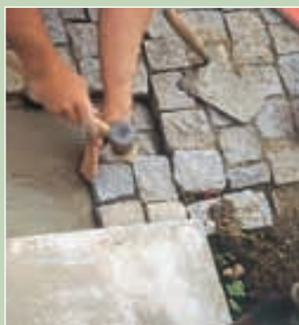
4. Bucățile debitate trebuie presate până la adâncimea corespunzătoare în patul de mortar, cât e încă umed.
