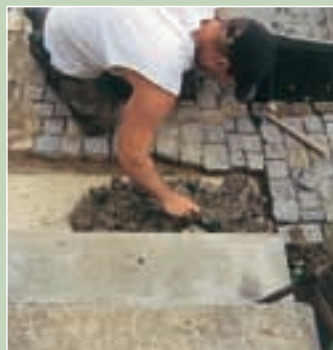
3. Pe treaptă trebuie așternut un pat de mortar pentru egalizare. După aplicare, acesta va fi nivelat ușor.
