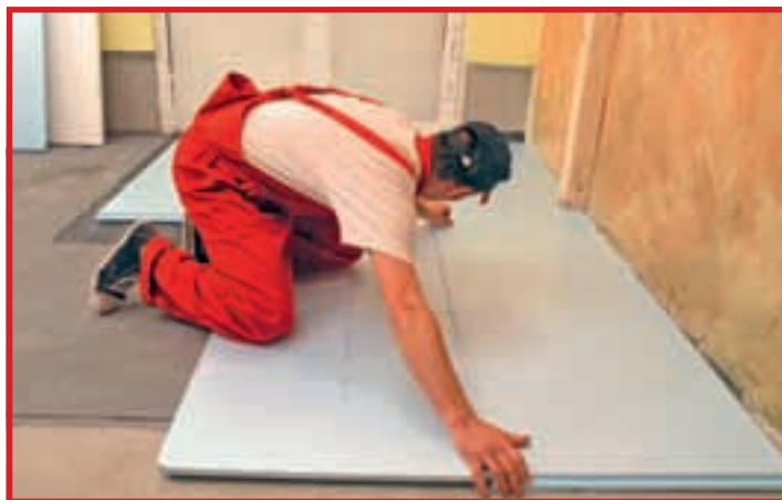
7. După cum vedeți, am folosit elemente extrudate prevăzute, pe margini, cu sistem nut-feder. Acestea asigură continuitate acoperirii.
