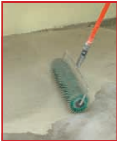
3. Pentru a evita persistența bulelor de aer în șapă, se va trece la dezaerarea sa.
