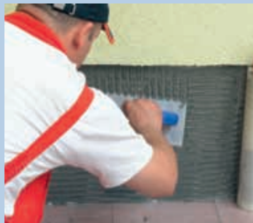
2. Procedul este același: înglobarea în adeziv a plasei, cu ajutorul gletierei metalice cu dinți de 8-10 mm.
