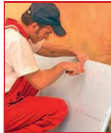
5. Acolo unde este necesar, polistirenul se poate tăia cu un cutter.
