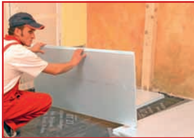
4. După aplicarea cartonului bitumar (la rece – cu un adeziv, sau la cald, aplicat de un specialist), începeți amplasarea exactă a plăcilor.
