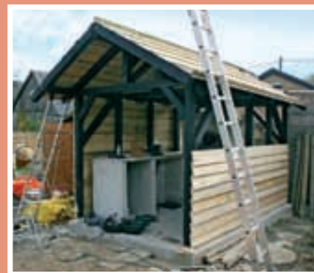
11. Structura portantă din grinzi de lemn a fost închisă cu scânduri brute dispuse lamelar, acoperișul în două ape fiind realizat cu țigla.
