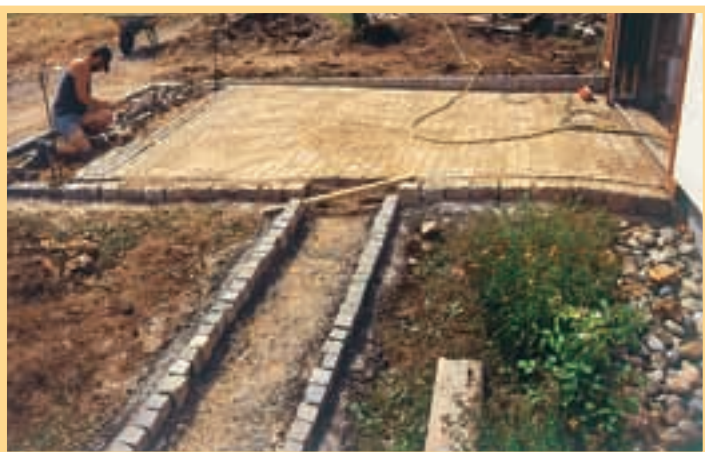
8. Așa cum se vede mai sus, traseul drumului de legătură este paralel cu fațada casei și perpendicular pe suprafața carosabilă.
