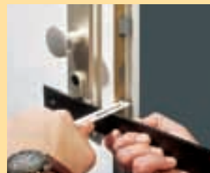
5. Doar după ce știți exact dimensiunile necesare, puteți procura un butuc adecvat.
