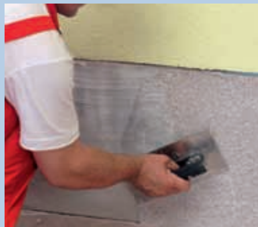
4. După ce termoizolația și grundul s-au uscat, se poate trece la tencuirea (sau placarea) soclului.
