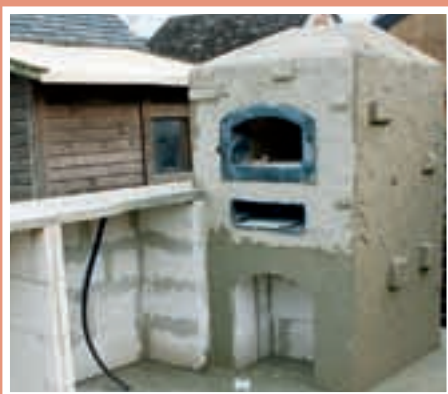
9. Aici s-a decis și construirea unei tejghele, alăturată nemijlocit cuptorului. Placa acesteia e din beton armat, iar nișa de sub ea din BCA.
