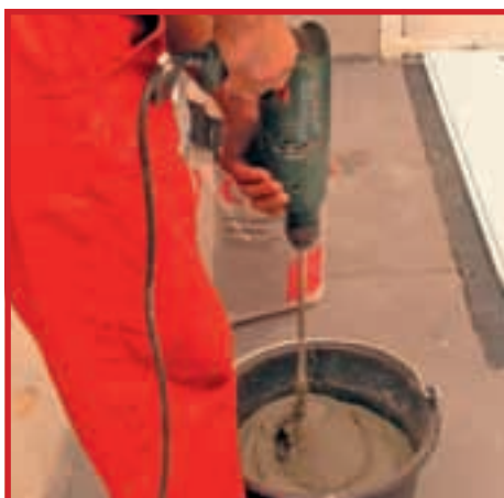
9. Prepararea mortarului se va face doar mecanic, respectând indicațiile producătorului.
