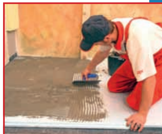
10. Un pat de adeziv aplicat cu gletiera va pregăti încorporarea plasei din fibră de sticlă.
