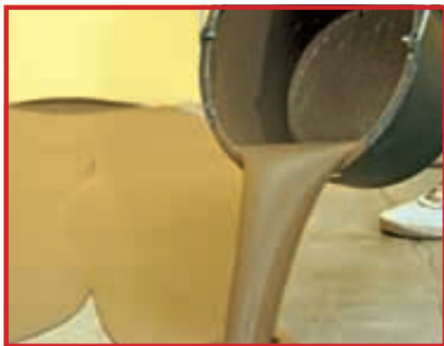
1. Dacă suprafața nu este plană, este necesară turnarea unei șape de egalizare, eventual autonivelantă.
