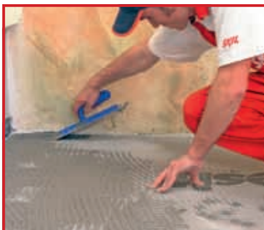
14. Interesul dumneavoastră este ca suprafața să devină, în final, cât mai regulată, inclusiv în zonele marginale.
