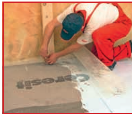
12. În zonele cu neregularități de formă, îndepărtați surplusul de plasă, care, altfel, ar deveni inestetic.
