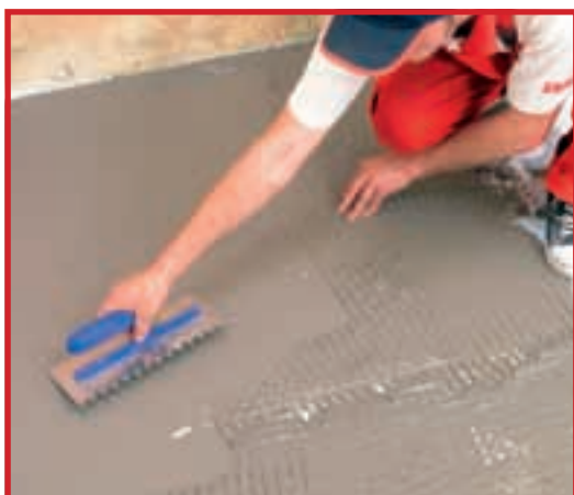
13. Înglobați armătura cu atenție în adeziv, trecând încă o dată cu partea nezimțată a gletierei.
