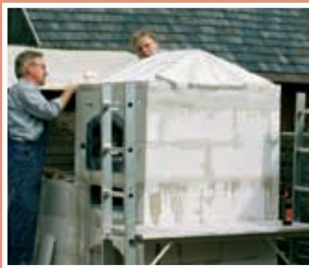
7. După montarea șuberului și a racordului la țeava de evacuare a fumului, a fost executat un acoperiș masiv din BCA.
