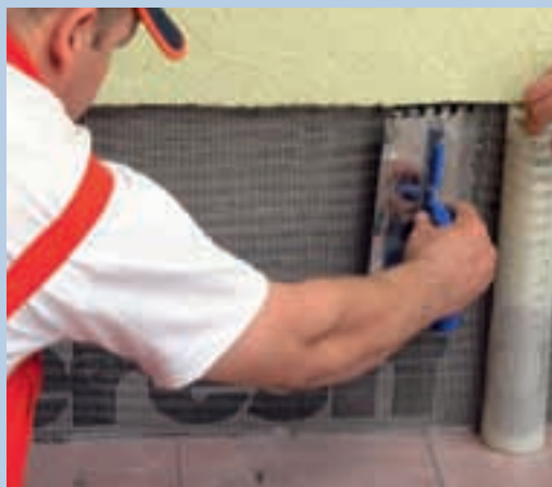
1. După ce au fost aplicate folia hidroizolantă și polistirenul, suprafața se armează cu plasă din fibră de sticlă.
