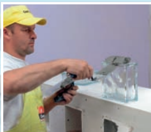
1. Un suport din gips-carton, pentru chiuvetă, poate fi decorat în mod inspirat prin inserarea unor cărămizi din sticlă incoloră sau colorată, clară ori satinată.
