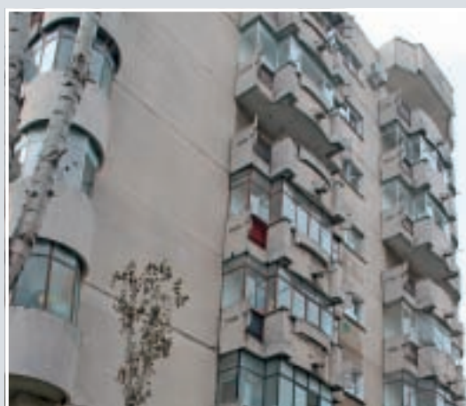
Perioada de tristă glorie a prefabricatelor din beton ne-a lăsat o moștenire pe care va trebui să o reconsiderăm.
