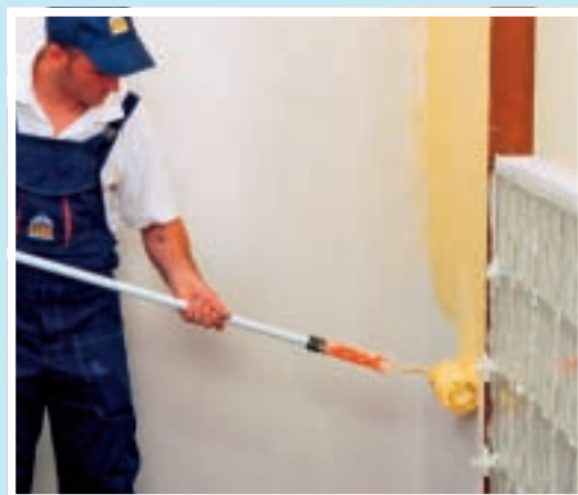
2. Până la uscare a adezivului, se pot executa operațiunile de finisare în zona pereților alăturați.
