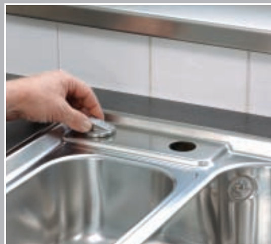
10. ... aparține sistemului de obturare al scurgerii. Prin urmare, acesta se poate închide mecanic, printr-o simplă apăsare de buton. În dreapta se vede decupajul pentru...
