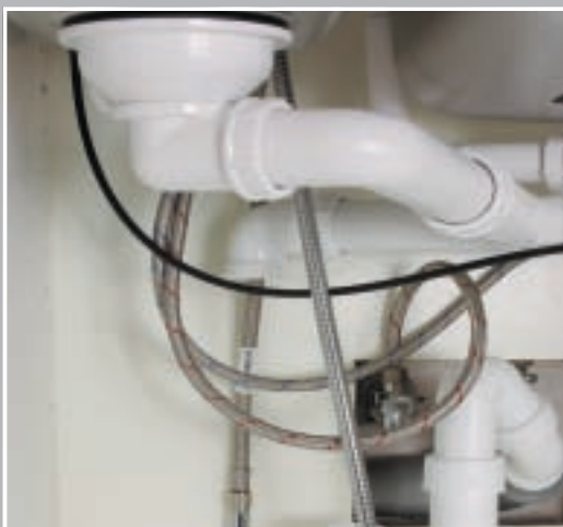
9. Țevile de scurgere aferente compartimentului bipartit de cuve se unesc și continuă până la clapeta de reținere a mirosului, unde se face racordul. Cablul negru...
