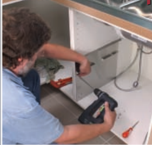
13. Acum e înșurubat în corpul dulapului primul element. Marginea îndoită din partea de sus servește ulterior ca suport pentru placa de acoperire. De aceea...
