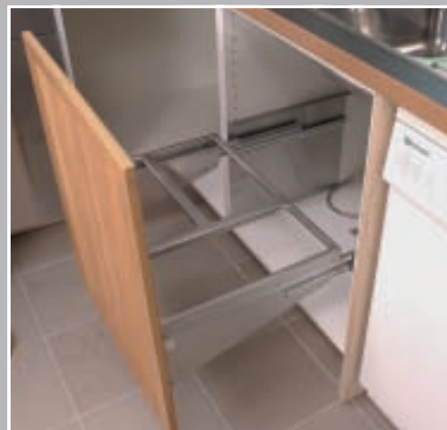
16. Iată cum e poziționată placa frontală față de cadrul glisant și modul în care e montat scheletul-suport. Profilele laterale solide din tablă servesc stabilității.
