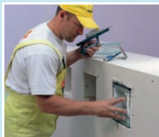
2. Locașurile prevăzute pentru introducerea dalelor trebuie atent confecționate pentru a nu fi nevoie de corecții ulterioare, prin decupare sau adaos de mortar.
