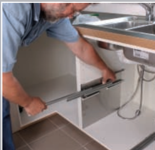
15. Sistemele de pârghii glisante vor fi așezate pe cornierele din tablă ale elementelor laterale. Apoi trebuie împinse și se vor fixa în mecanismul de blocare.
