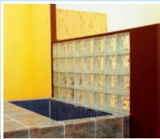
3. Zidul de sticlă poate fi încadrat fără probleme de o construcție din gips-carton, realizată ulterior.
