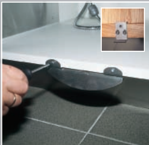
17. Montarea pedalei acționate cu piciorul: ea se fixează frontal, în mijloc, la baza dulapului. Pe ușă va fi înșurubată contrapiesa cu rol de blocare.
