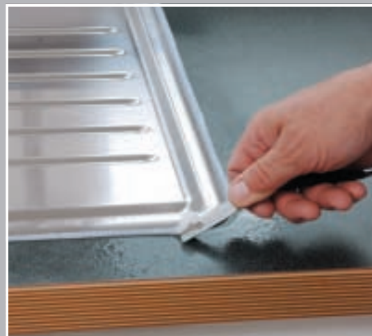
6. ... siliconul. În acest fel se va realiza și etanșarea. Eventualele excedente de silicon vor fi îndepărtate cu un șpaclu mic din material plastic (vezi și „Sfatul nostru“).
