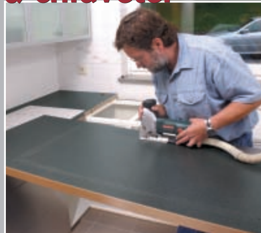
2. ... profesionistul nostru pregătește frontul de lucru în vederea introducerii pânzei de ferăstrău pendular. Apoi el decupează exact porțiunea respectivă din placa groasă.
