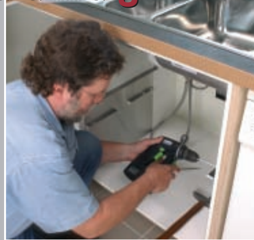
14. ... ambele elemente laterale trebuie înșurubate bine pentru ca sus placa de acoperire să stea drept, iar gălețile să nu rămână cumva prinse în ea.
