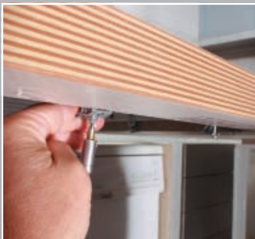
5. Acum sunt montate prin înșurubare clemele de fixare pe marginea blatului de lucru. Cu ajutorul lor, chiuveta va fi încorporată ferm în blat, fiind totodată presat și...
