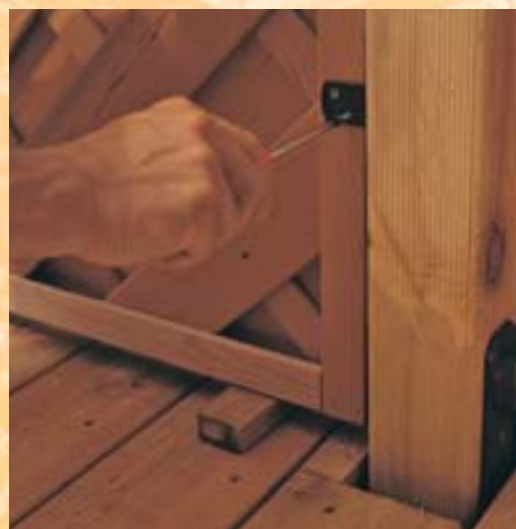
10. Apoi au fost așezate panourile gardului pe distanțieri, potrivite spațiile dintre stâlpi și fixate în șuruburi de piesele metalice.
