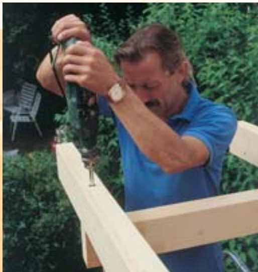
14. Capetele hexagonale ale șuruburilor trebuie să intre complet în lemn. În acest scop, au fost date în prealabil găurile corespunzătoare cu un burghiu.
