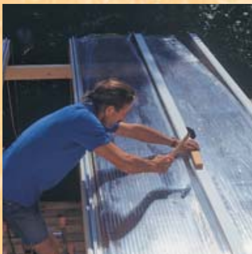
17. Panourile acoperișului au fost așezate, fixat profilul superior și blocată piesa de acoperire. Folia de protecție va fi scoasă complet la încheierea lucrării.
