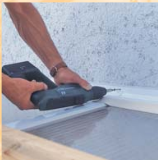
18. Pentru a nu se infiltra nici o picătură de apă între casă și terasă, a fost folosit un profil de racordare la perete. În plus, a fost etanșeizată zona cu silicon.
