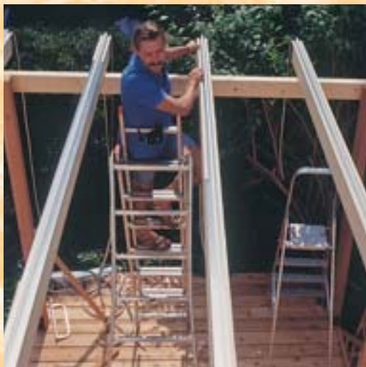
16. ...și apoi garniturile de etanșeizare. Deși ulterior plăcile vor fi prinse între aceste garnituri de etanșeizare, sunt posibile unele mișcări de dilatare.
