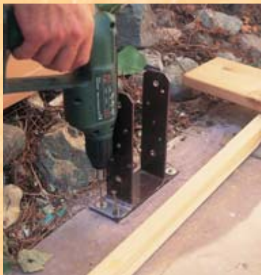
5. Acum este momentul în care a fost fixat suportul stâlpilor. Toate materialele metalice folosite pentru această lucrare trebuie să fie inoxidabile.
