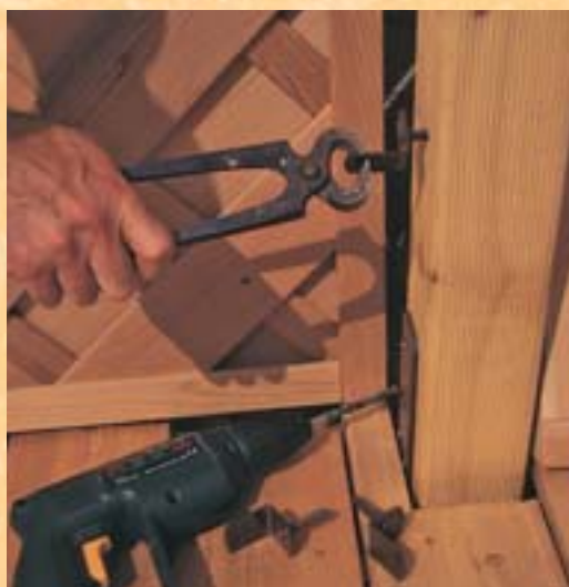
9. Panourile gardului au fost montate pe stâlpi cu piese metalice. În prealabil, au fost executate găurile și fixați suportii prin înșurubare, cu un clește.
