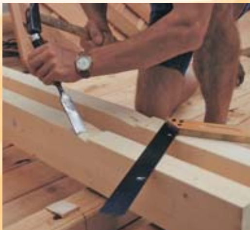
13. Căpriorii acoperișului au fost montați în pantă. Pentru ca aceștia să se așeze complet pe grinzile transversale, au fost ajustați cu ciocanul și dalta.
