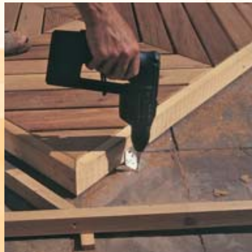
2. Primul element care a fost montat este cel de efect al pardoselii (format din două pătrate). El a fost fixat în placa din beton cu ajutorul unor corniere.
