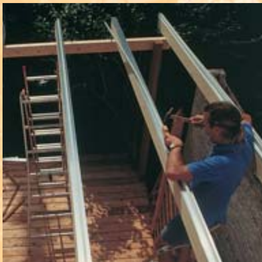
15. Panourile acoperișului au fost fixate cu ajutorul unui sistem de profile. A fost înșurubat profilul de bază, introdus prin batere un profil intermediar în el...
