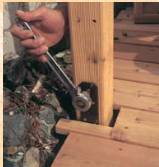
6. După ce au fost date găurile corespunzătoare, au fost potriviți, îndreptați și montați stâlpii. Muchia de tăiere a scândurii pardoselii a fost țesită cu atenție.
